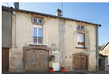
Face antérieure du n° 77. Phot. Jérôme Mongreville IVR43_20217000679NUC4A
