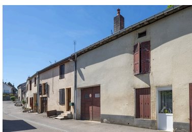
Trois quarts droit des façades vers le sud, à hauteur du n° 29.
