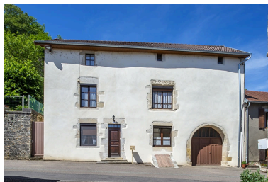
Face antérieure du n° 37. Phot. Jérôme Mongreville IVR43_20217000361NUC4A
