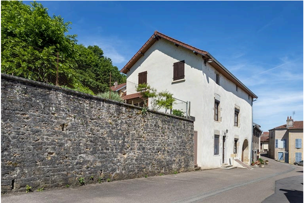
Trois quarts de la façade, du mur de soutènement du jardin et du pignon sud du n° 37.
