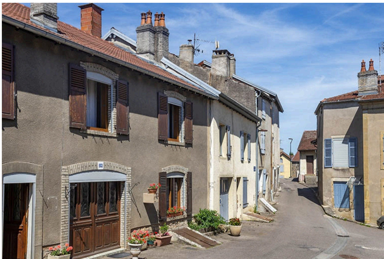
Trois quarts gauche des façades vers le nord, à hauteur du n° 39.
