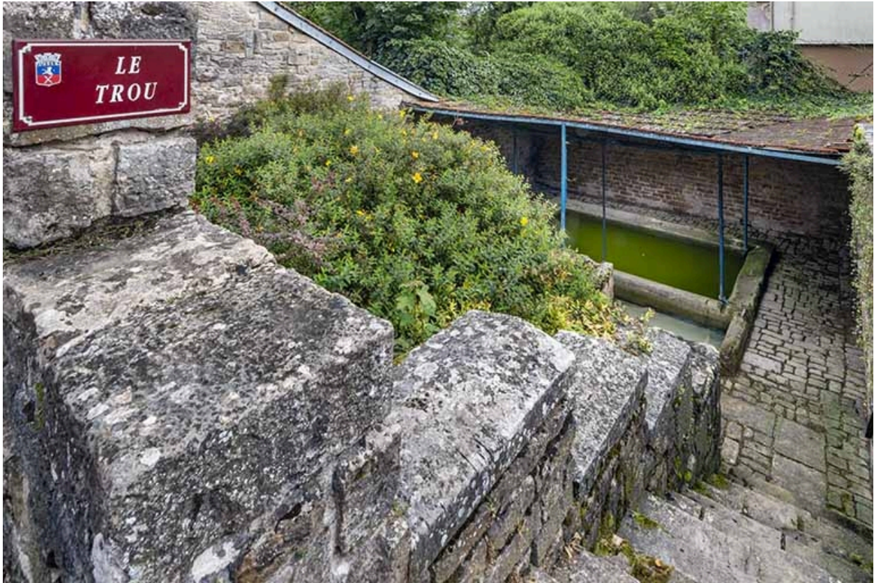
Le trou, au n° 6. Vue plongeante depuis la rue sur les bassins.
