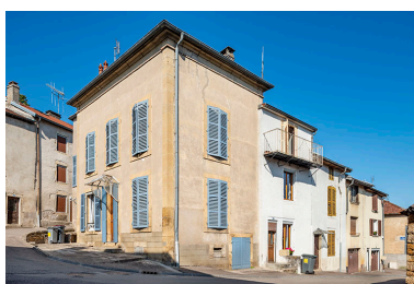
Trois quarts droit du n° 41 et des façades adjacentes de la rue Patet-Tournante. Phot. Jérôme Mongreville IVR43_20217000569NUC4A
