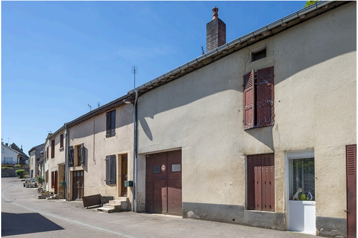
Trois quarts droit des façades vers le sud, à hauteur du n° 29.
