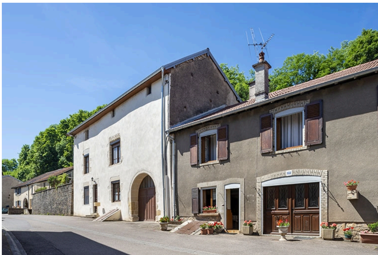
Trois quarts de la façade, du mur de soutènement du jardin et du pignon nord du n° 37 et de la façade du n° 39.
