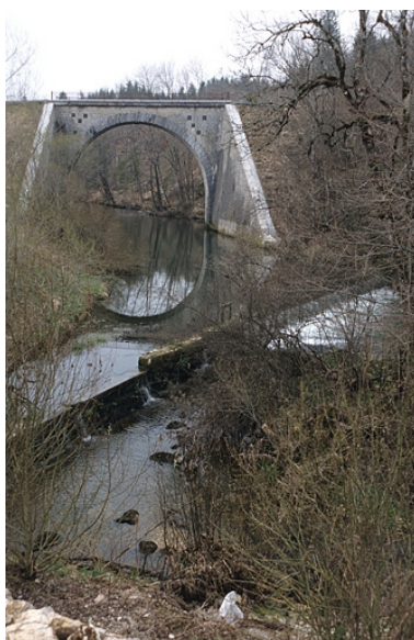
Pont sur l'Angillon : vue d'ensemble, depuis l'ouest (aval, rive droite). Au premier plan, le barrage de l'ancienne usine de menuiserie de la société des Constructions métalliques Fillod.
