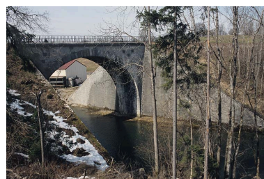
Pont sur l'Angillon : vue d'ensemble, depuis l'est (amont, rive gauche). Phot. Yves Sancey IVR43_20053900053ZA
