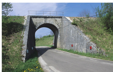
Pont sur la route départementale n° 27 : vue d'ensemble, depuis l'est. Phot. Yves Sancey IVR43_20053900060ZA
