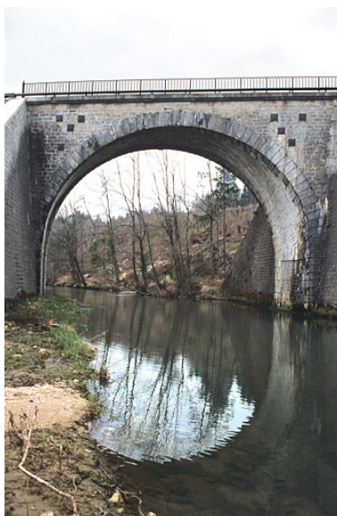
Pont sur l'Angillon : tête ouest (aval), appareil hélicoïdal. Phot. Yves Sancey IVR43_20053900055ZA
