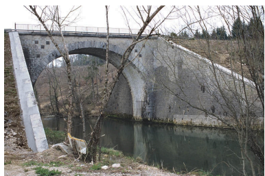
Pont sur l'Angillon : tête ouest (aval). Phot. Yves Sancey IVR43_20053900057ZA
