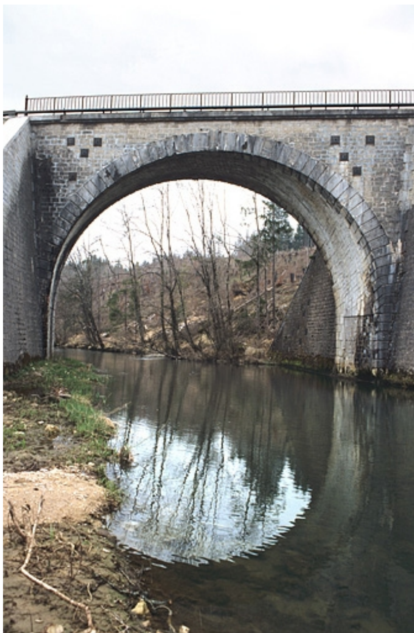
Pont sur l'Angillon : tête ouest (aval), appareil hélicoïdal.
