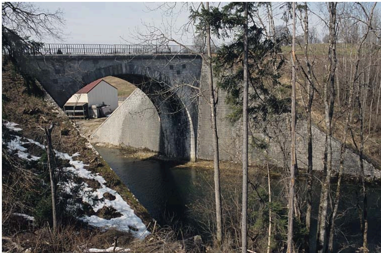
Pont sur l'Angillon : vue d'ensemble, depuis l'est (amont, rive gauche).
