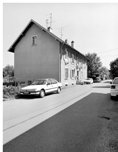
Logement ouvrier à 4 appartements. Phot. Yves Sancey IVR43_20009000504X
