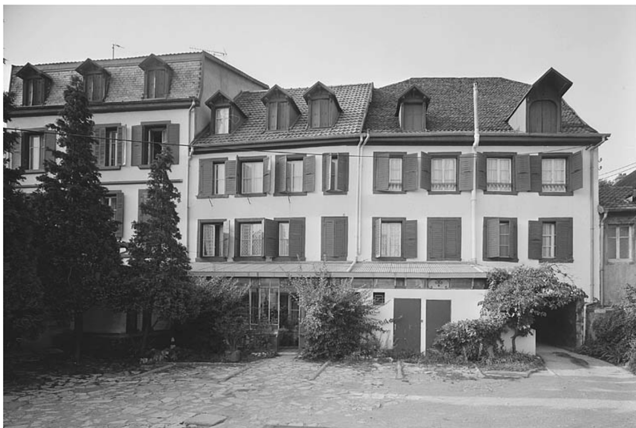
Façades sur jardin.
