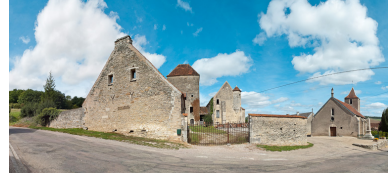
Vue d'ensemble du château. Phot. Pierre-Marie Barbe-Richaud IVR26_20112104104NUC4AQ
