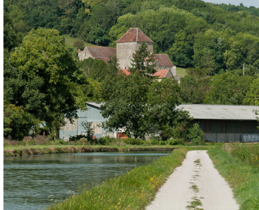
Vue du château depuis le canal. Phot. Pierre-Marie Barbe-Richaud IVR26_20112104090NUC4AQ
