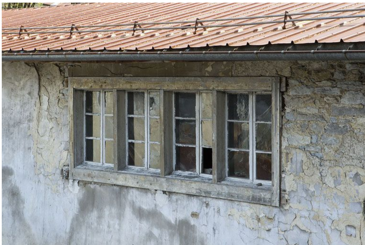
Fenêtres lunetières de l'aile sud.
