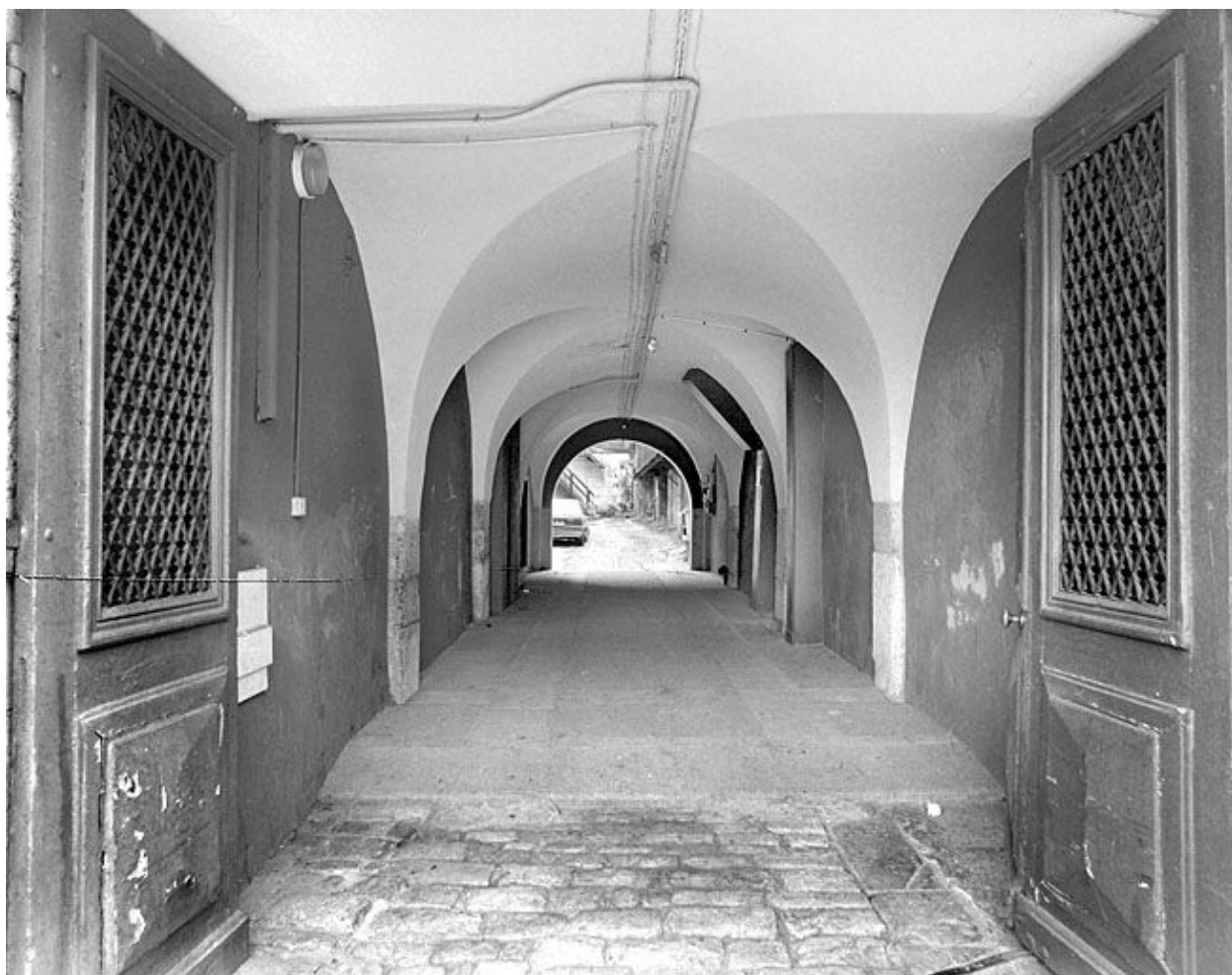
Passage couvert, depuis la rue.
