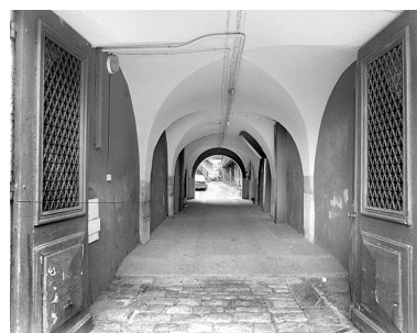
Passage couvert, depuis la rue. Phot. Yves Sancey IVR43_20033900598X
