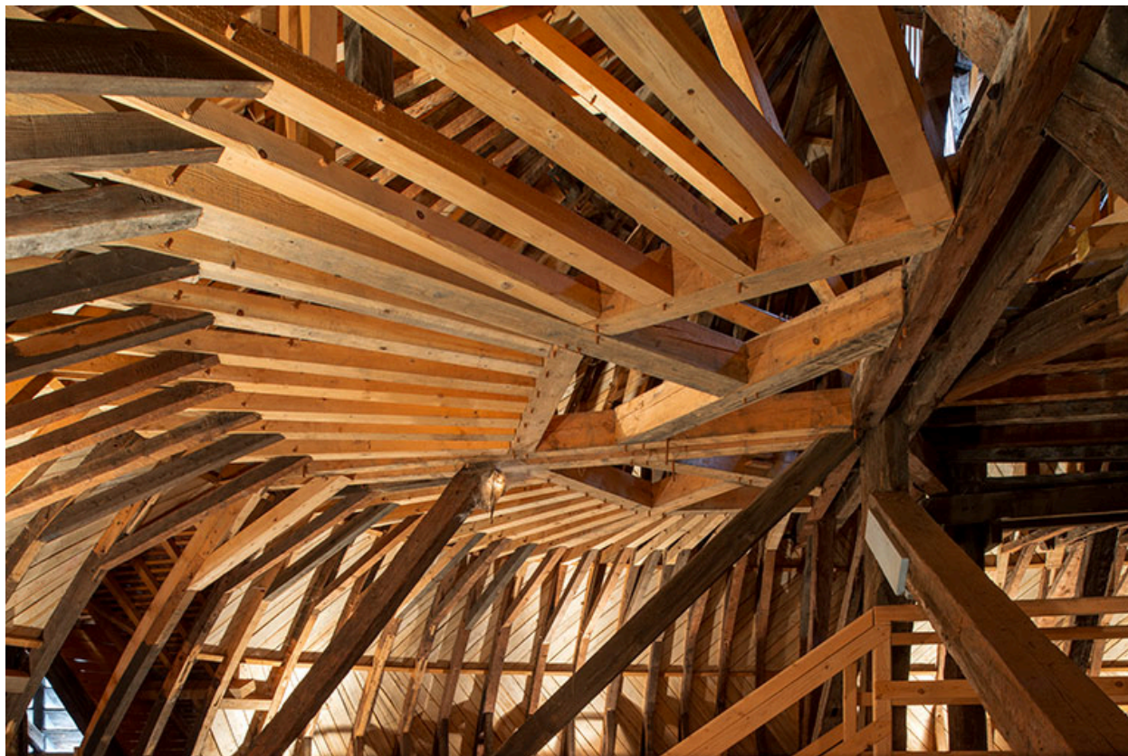
Enrayure du côté occidentale, depuis le sud.
