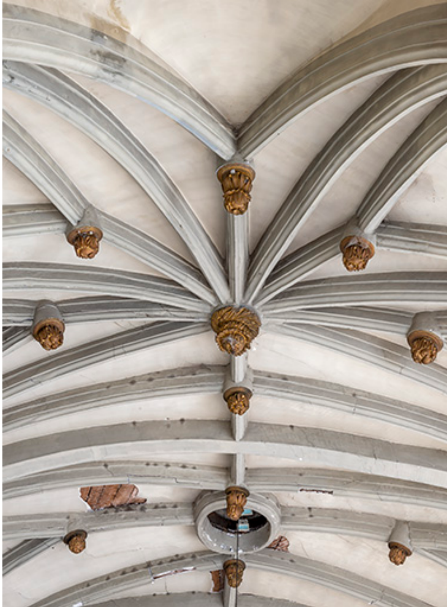
Les nervures du voûtement.
