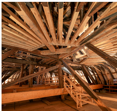
Vue d'ensemble depuis le nord-ouest. Phot. Nicolas Waltefaugle IVR43_20253900287NUC4A
