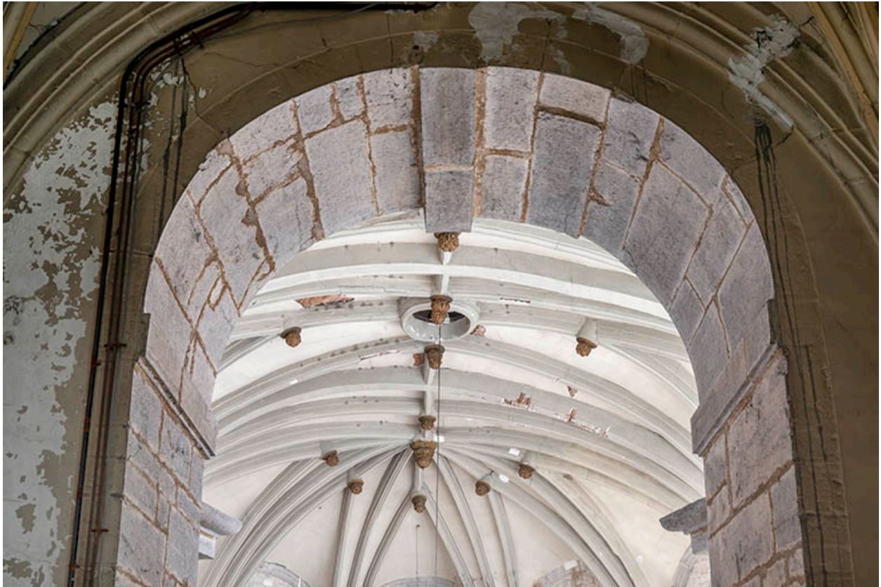
Voûtement de la chapelle depuis l'étage de la sacristie.
