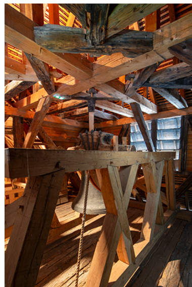
Campanile de la sacristie. Charpente du beffroi. Phot. Nicolas Waltefaugle IVR43_20253900289NUC4A
