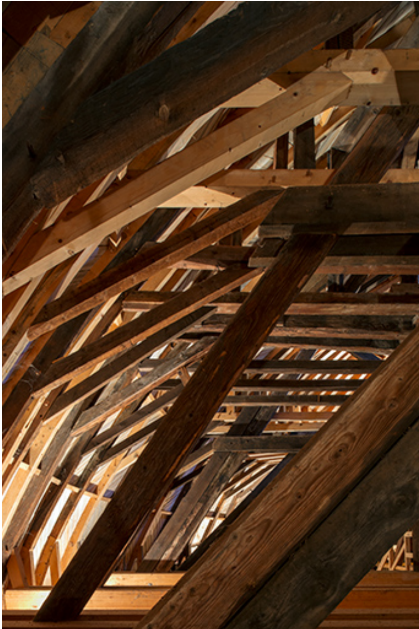
Côté sud de la charpente du dôme.
