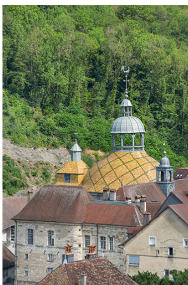
Vue plongeante depuis le sud-est. Phot. Jérôme Mongreville IVR43_20233900935NUC4A
