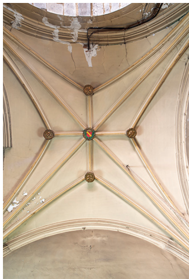
Voûtement de la chapelle axiale (et sacristie). Phot. Jérôme Mongreville IVR43_20223900903NUC4A
