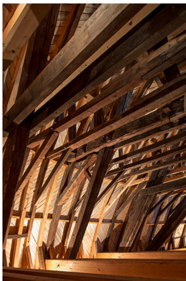
Partie sud de la charpente du dôme, vue de trois quarts. Phot. Nicolas Waltefaugle IVR43_20253900348NUC4A
