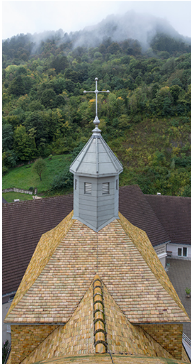
Toiture de la sacristie, depuis le lanterneau.
