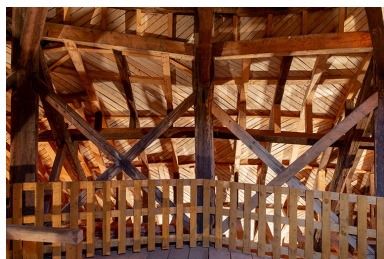
Côté nord vu de face, depuis le niveau intermédiaire. Phot. Nicolas Waltefaugle IVR43_20253900279NUC4A
