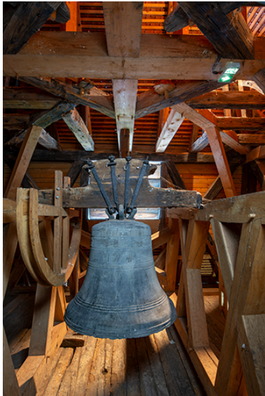
Charpente du beffroi : la cloche et son joug. Phot. Nicolas Waltefaugle IVR43_20253900290NUC4A
