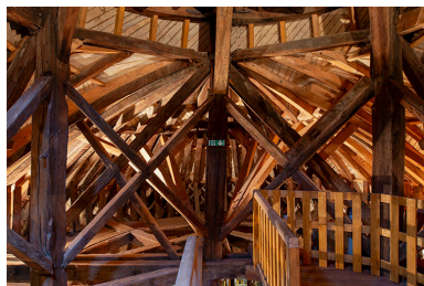
Partie orientale de la charpente, depuis le niveau intermédiaire. Vue axiale. Phot. Nicolas Waltefaugle IVR43_20253900276NUC4A
