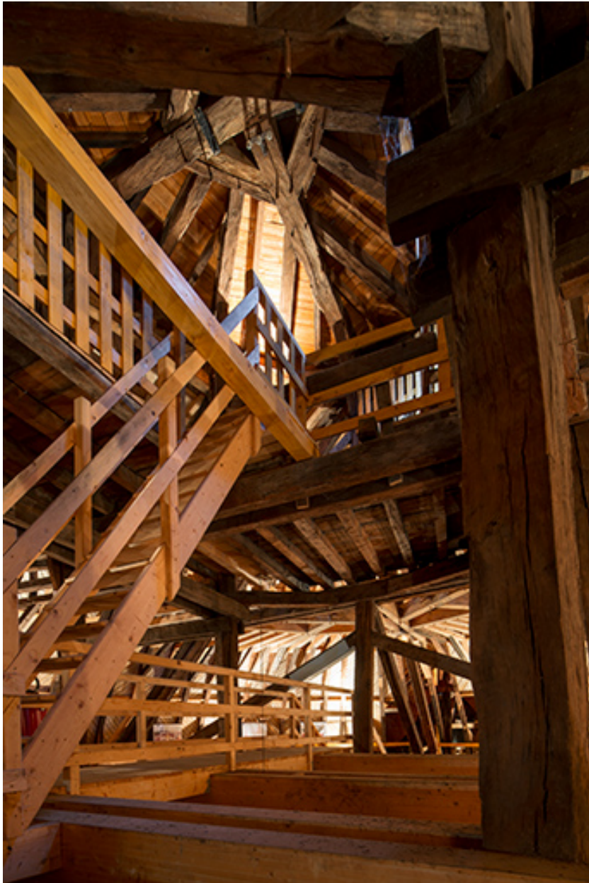
Beffroi du dôme, en contre-plongée, depuis l'est.
