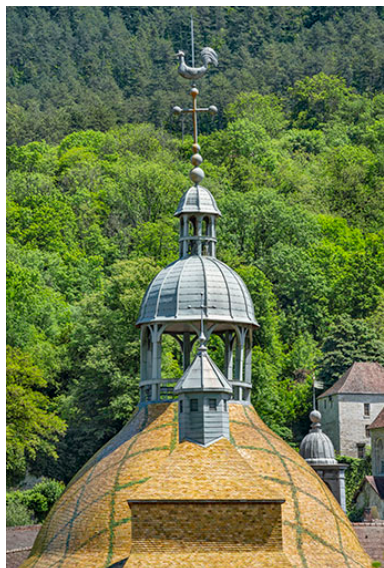
Vue du dôme depuis l'ouest. Phot. Jérôme Mongreville IVR43_20243900830NUC4A
