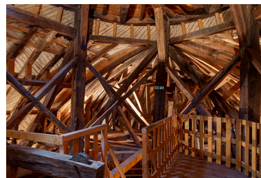
Vue de trois quarts, depuis le niveau intermédiaire, vers le nord-ouest. Phot. Nicolas Waltefaugle IVR43_20253900278NUC4A
