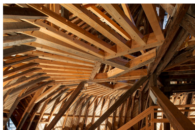
Enrayure du côté occidentale, depuis le sud. Phot. Nicolas Waltefaugle IVR43_20253900349NUC4A
