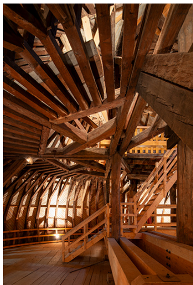
Partie orientale de la charpente du dôme, depuis le nord. Phot. Nicolas Waltefaugle IVR43_20253900283NUC4A
