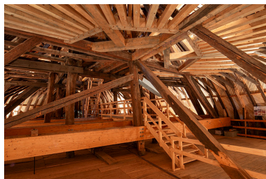
Vue d'ensemble depuis le nord-ouest. Vue rapprochée. Phot. Nicolas Waltefaugle IVR43_20253900286NUC4A
