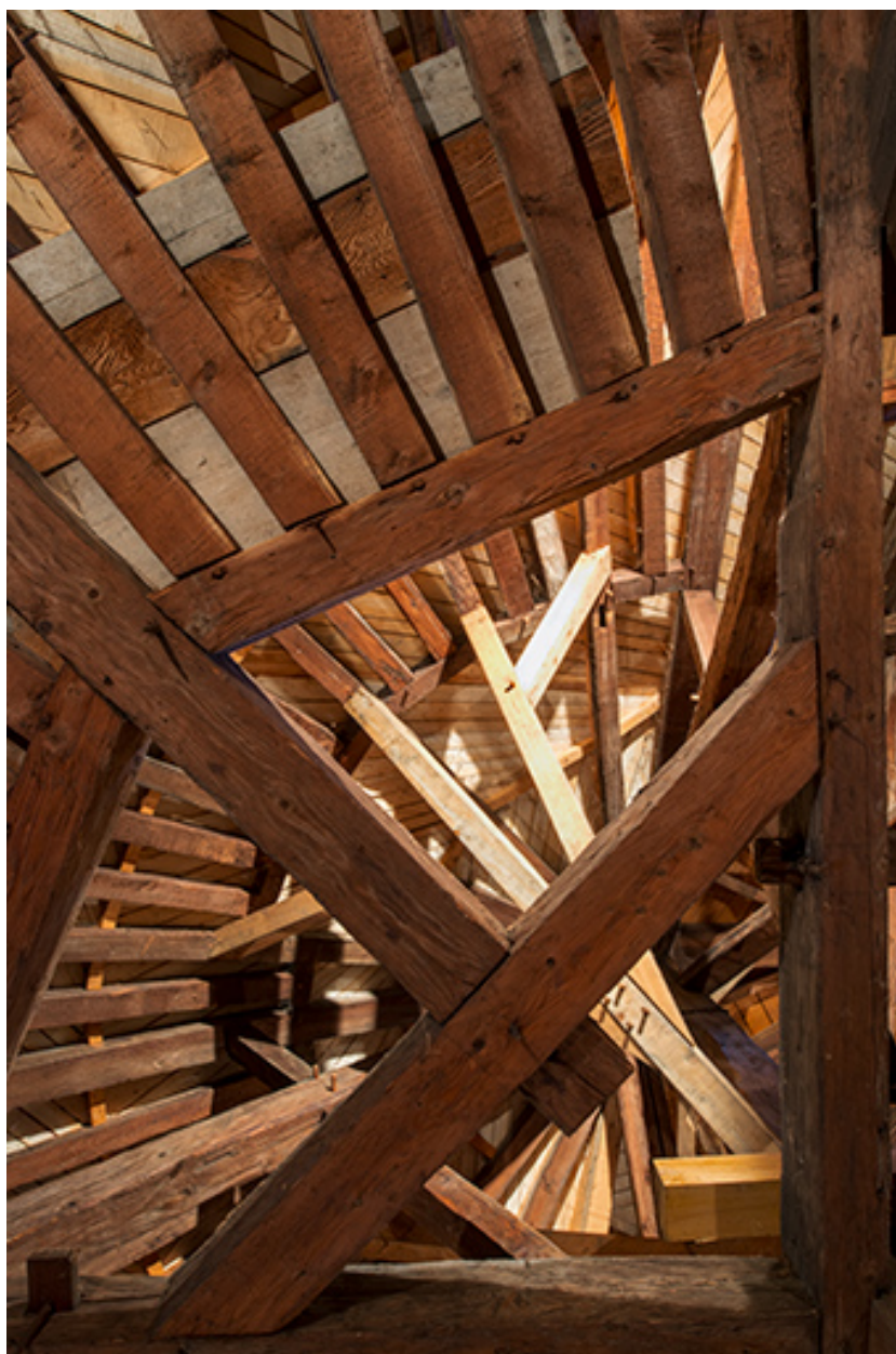
Enrayure nord-est de la charpente du dôme.
