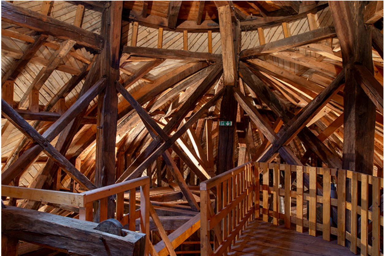
Vue de trois quarts, depuis le niveau intermédiaire, vers le nord-ouest.
