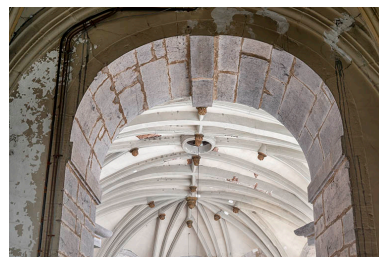
Voûtement de la chapelle depuis l'étage de la sacristie. Phot. Jérôme Mongreville IVR43_20223900905NUC4A
