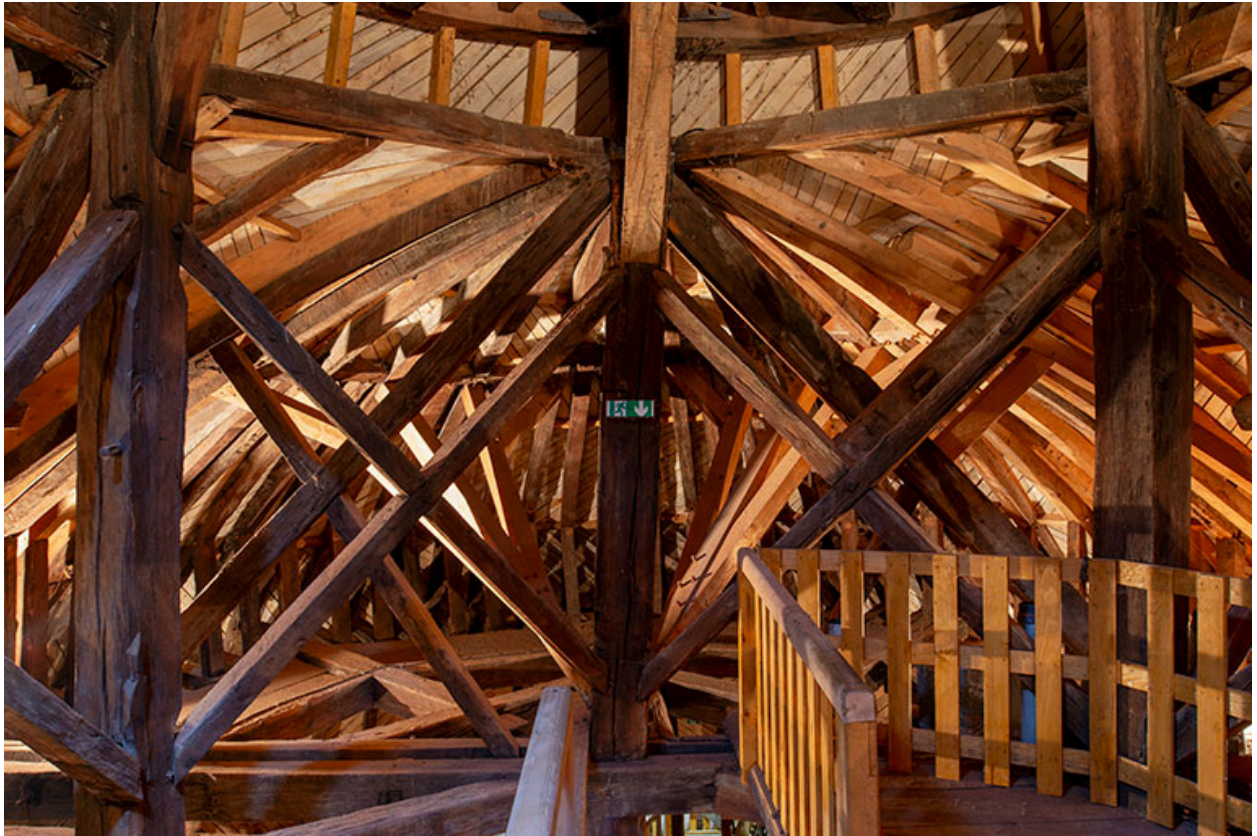
Partie orientale de la charpente, depuis le niveau intermédiaire. Vue axiale.
