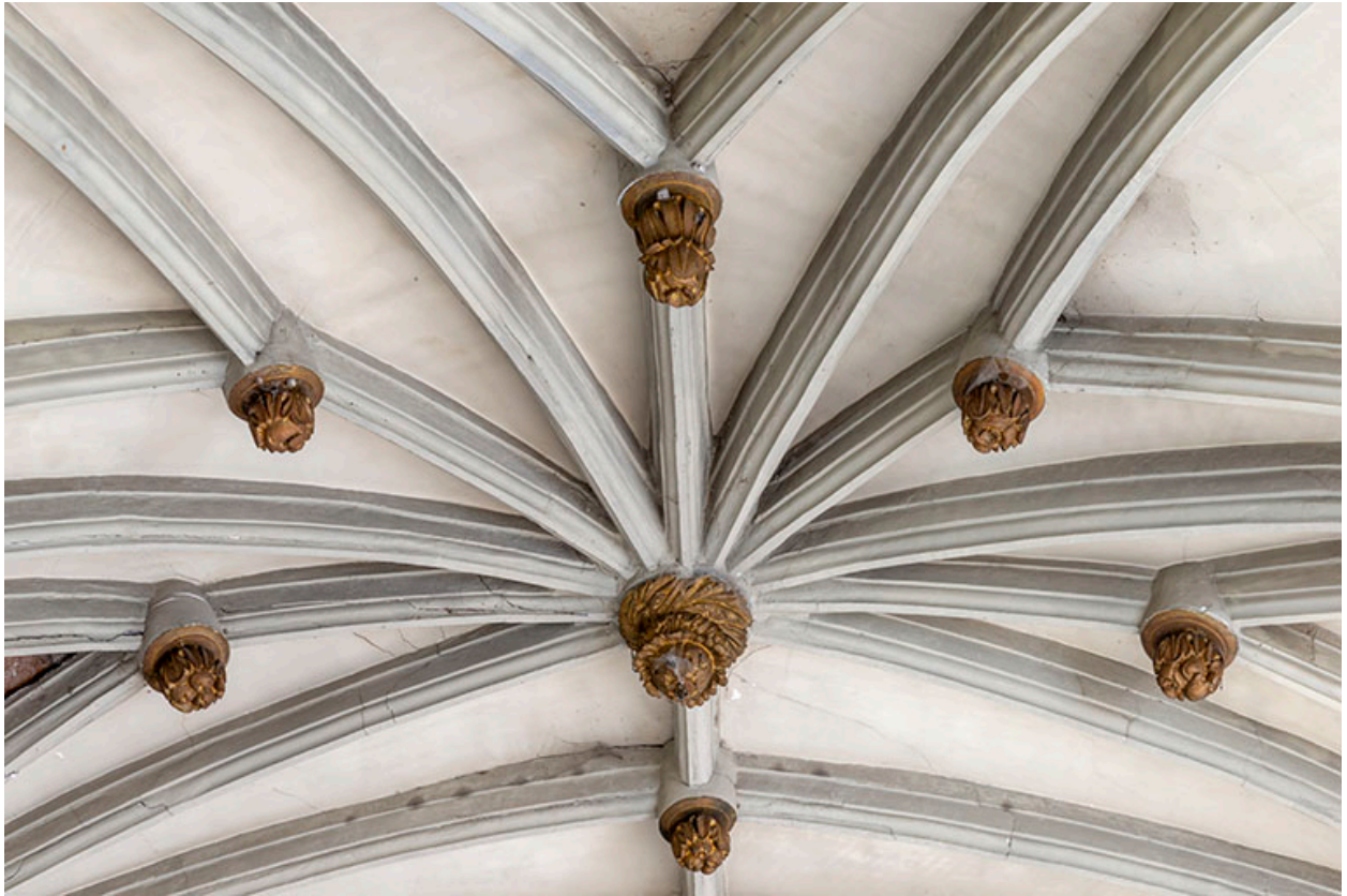
Détail de la partie sommitale des ogives.
