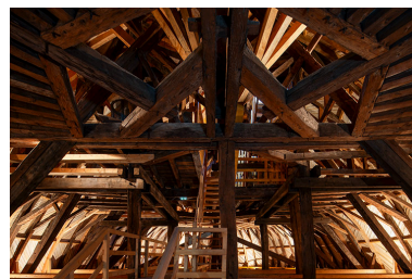
Vue axiale de la charpente du dôme, depuis l'est. Vue rapprochée. Phot. Nicolas Waltefaugle IVR43_20253900285NUC4A
