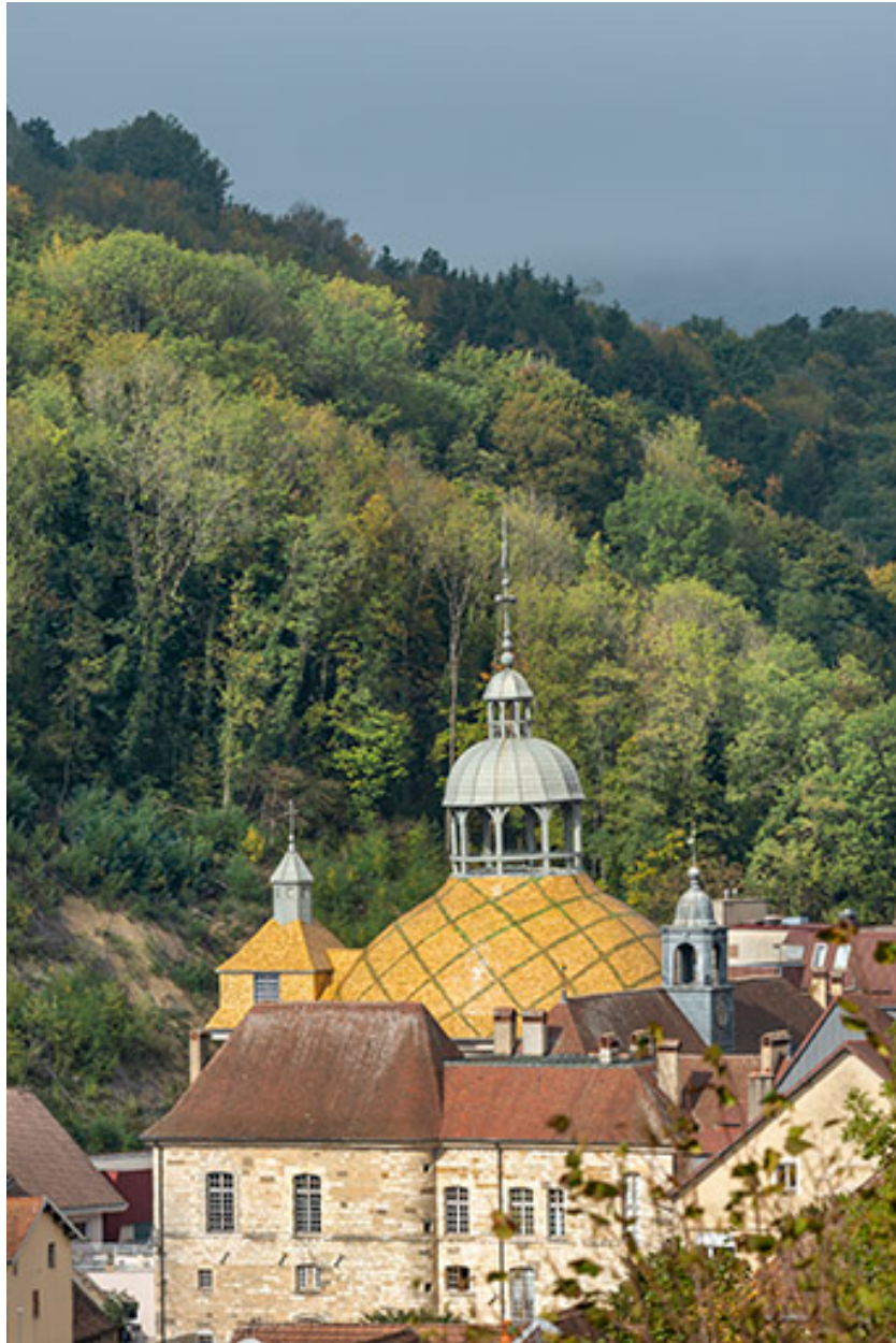
Vue d'ensemble depuis le sud-est.
