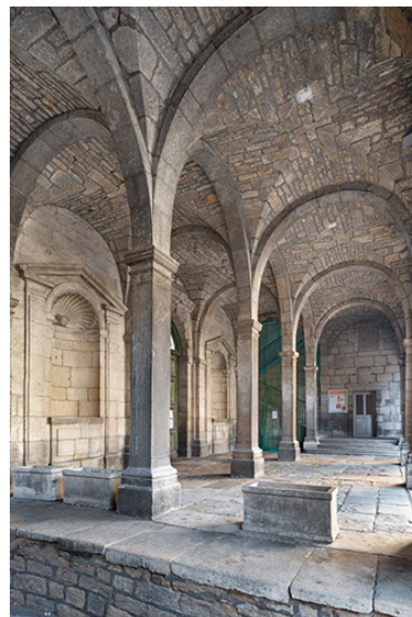
Parvis couvert (hôtel de ville). Vue de trois quarts gauche. Phot. Jérôme Mongreville IVR43_20223901273NUC4A
