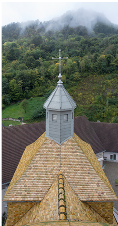
Toiture de la sacristie, depuis le lanterneau. Phot. Nicolas Waltefaugle IVR43_20253900263NUC4A
