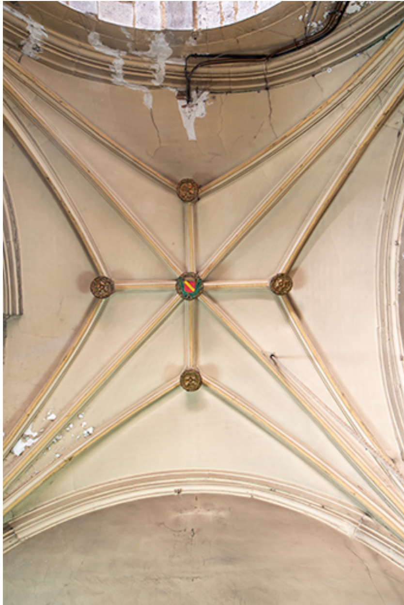
Voûtement de la chapelle axiale (et sacristie).
