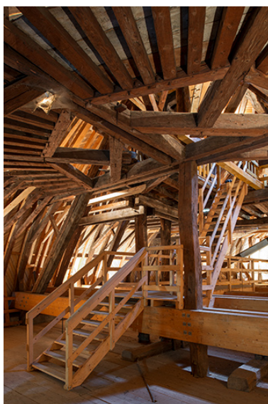
Vue de la charpente du dôme, depuis le nord-est. Phot. Nicolas Waltefaugle IVR43_20253900345NUC4A
