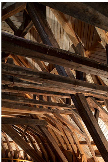
Coté sud, vu depuis l'ouest. Phot. Nicolas Waltefaugle IVR43_20253900350NUC4A
