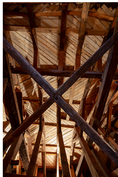
Partie nord depuis le niveau intermédiaire. Entretoise en croix de Saint-André. Phot. Nicolas Waltefaugle IVR43_20253900280NUC4A
