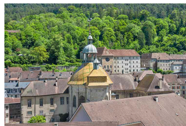
Vue d'ensemble depuis l'ouest. Phot. Jérôme Mongreville IVR43_20243900829NUC4A
