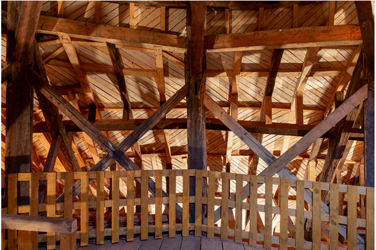
Coté nord vu de face, depuis le niveau intermédiaire.
