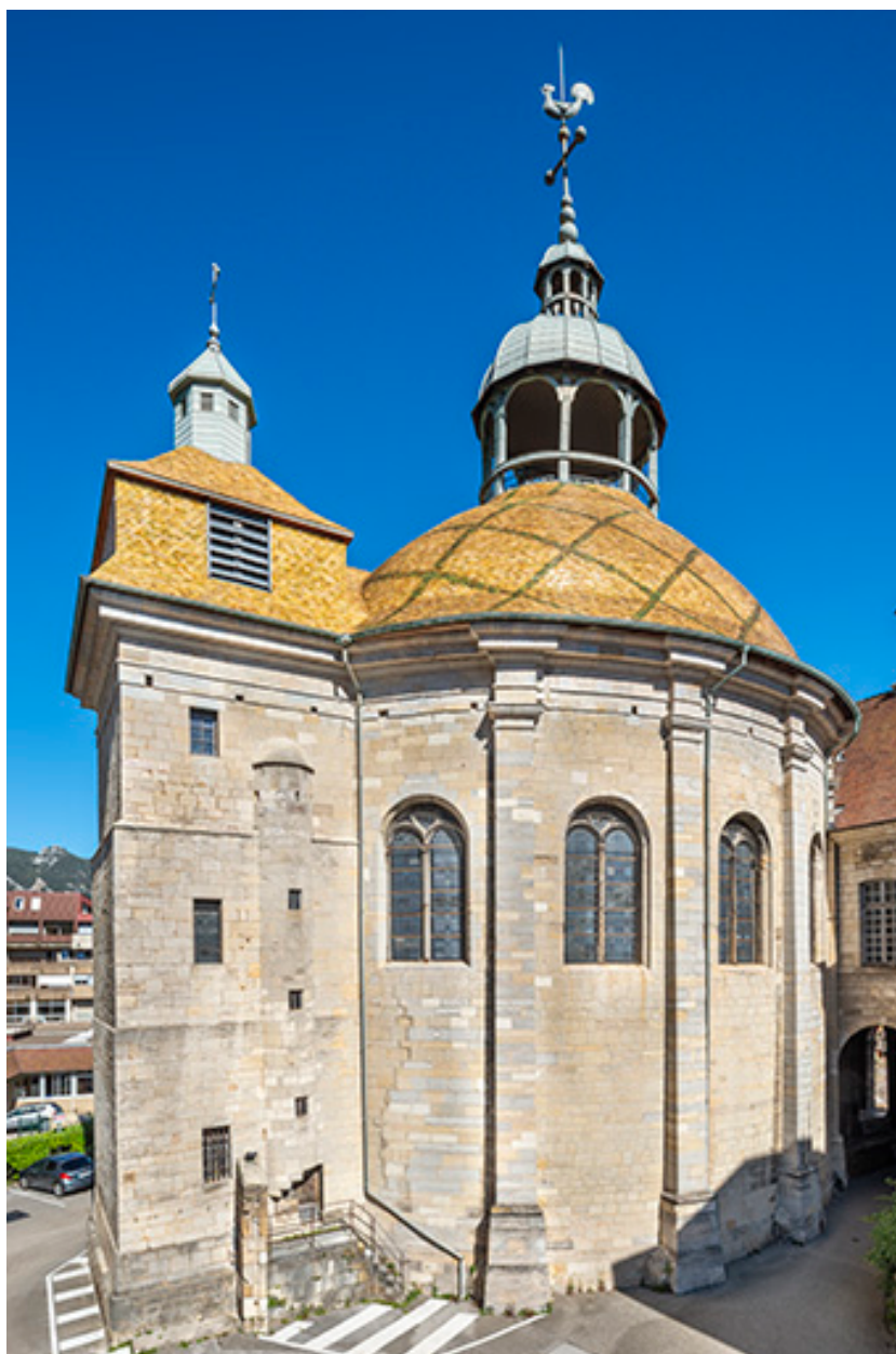
Vue d'ensemble depuis le sud-ouest.
