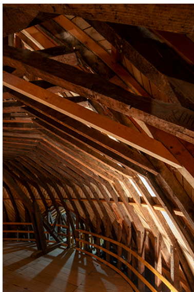
Partie orientale de la charpente, depuis le sud. Phot. Nicolas Waltefaugle IVR43_20253900284NUC4A
