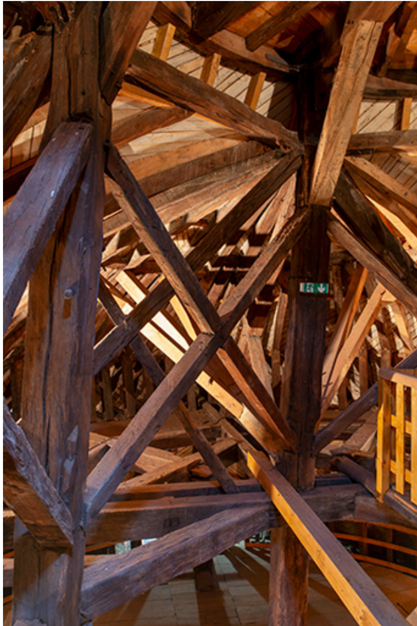
Entretoise du niveau intermédiaire, côté nord.
