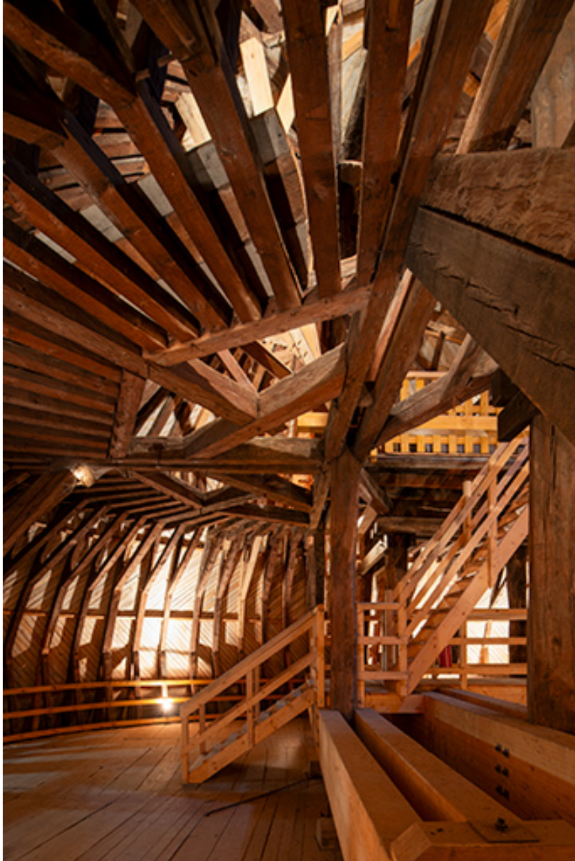
Partie orientale de la charpente du dôme, depuis le nord.
