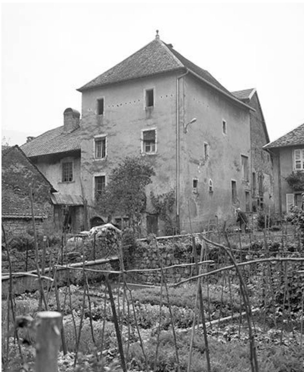
Façade antérieure et face latérale droite.
