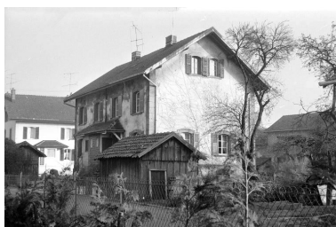
Façades antérieure et latérale droite.
