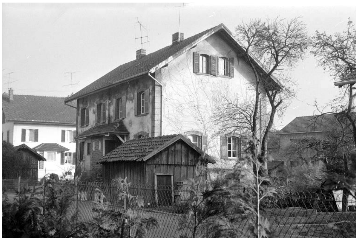
Façades antérieure et latérale droite.
