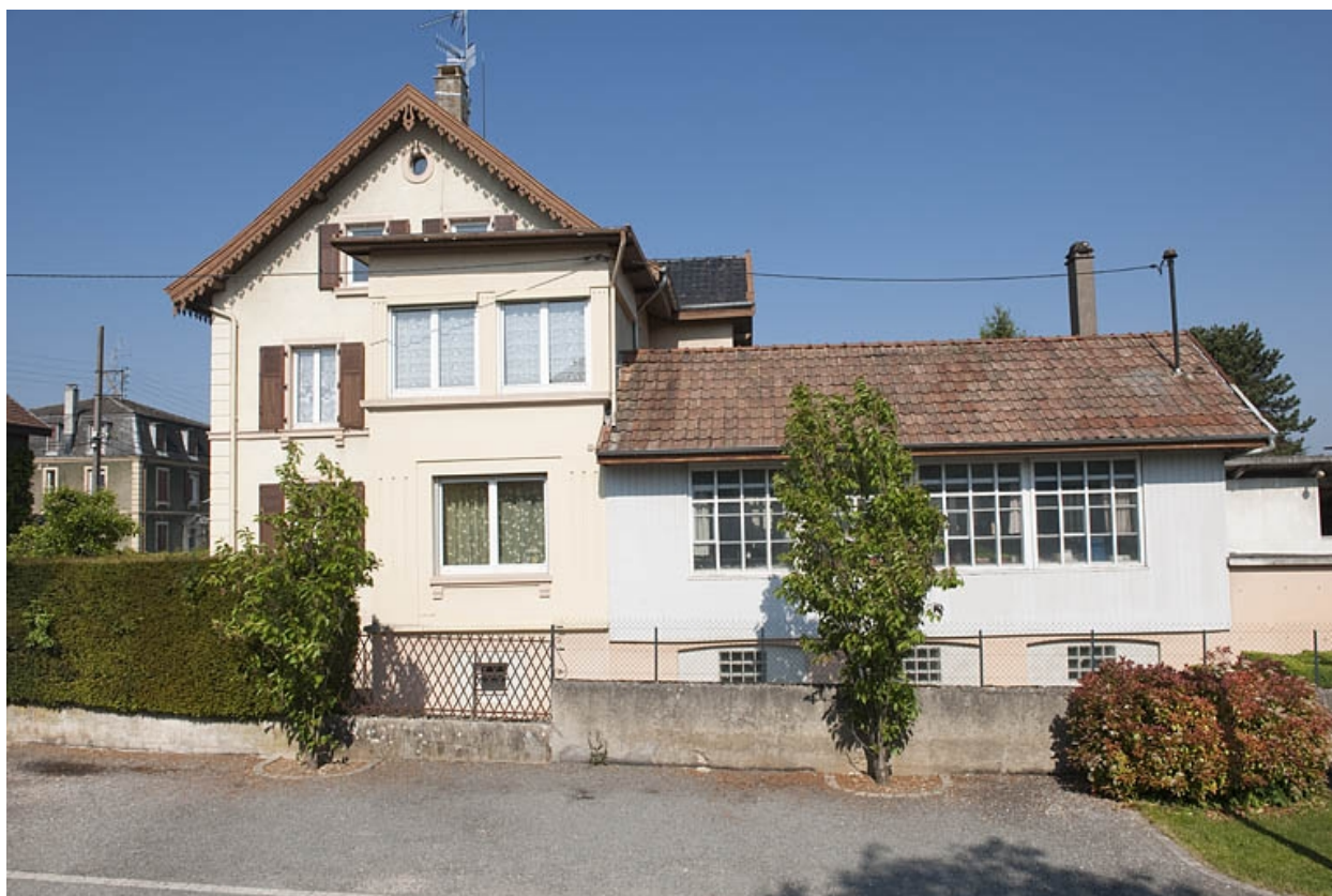
Pignon et façade sud de l'atelier.
