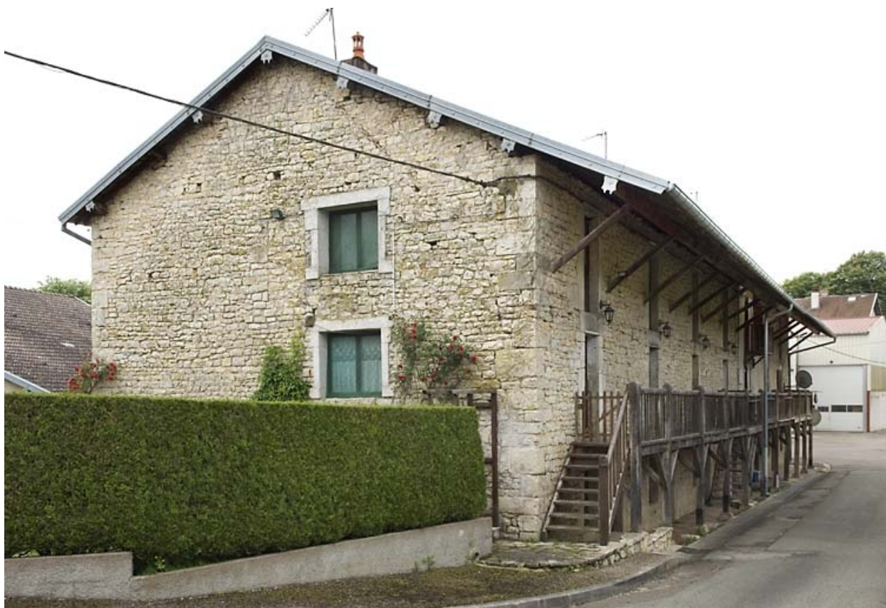
Façade sur rue du logement ouvrier.
