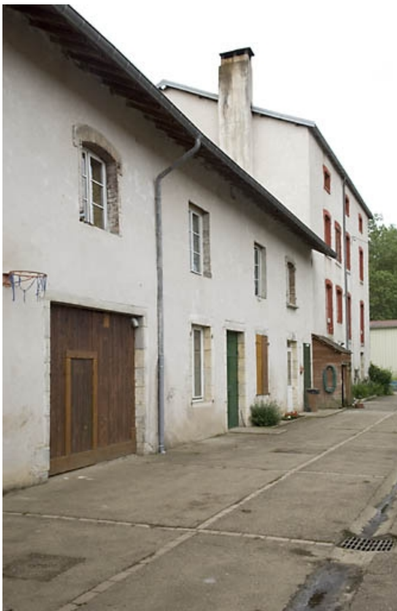
Façade nord vue de trois quarts gauche.
