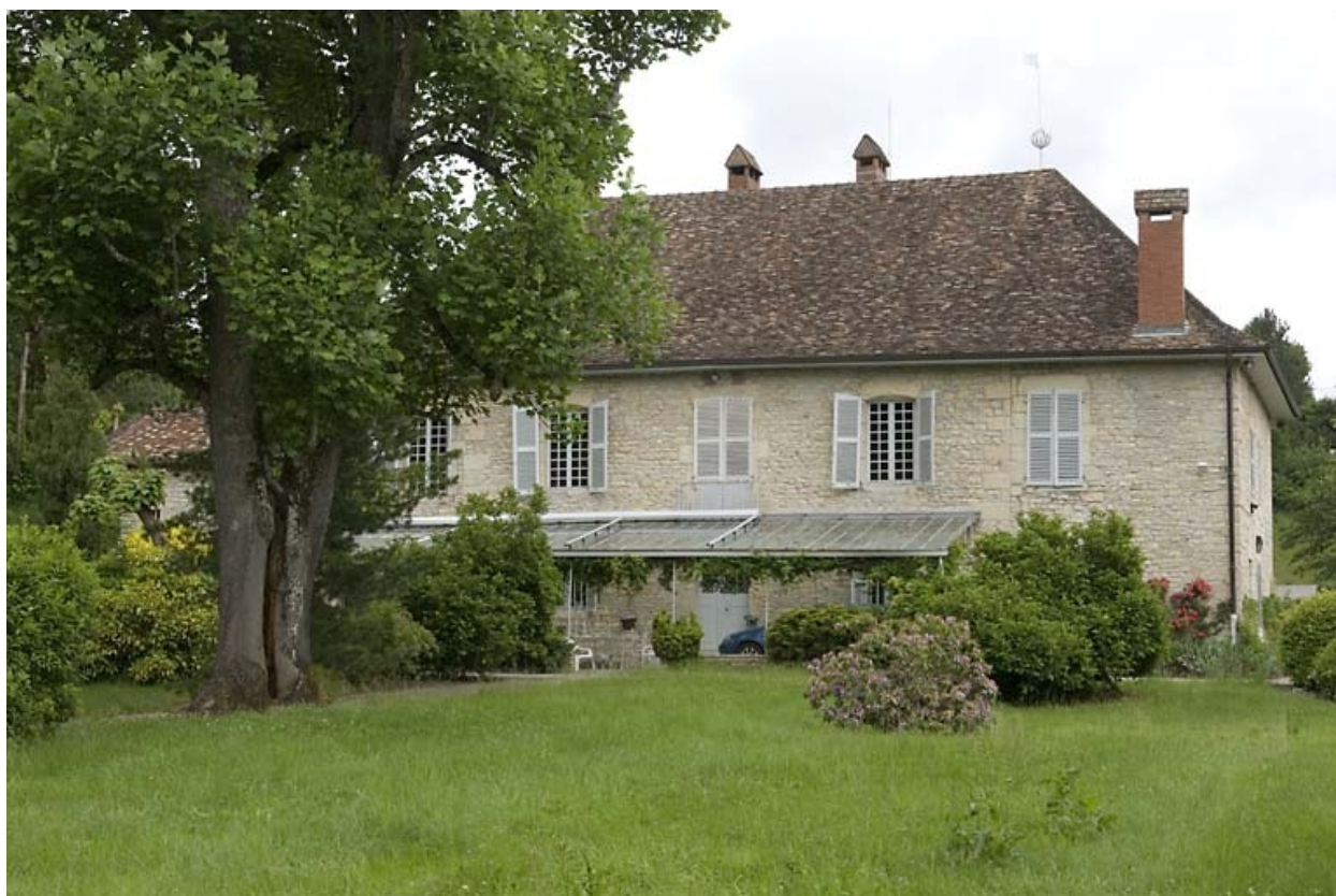
Façade antérieure du logement patronal.
