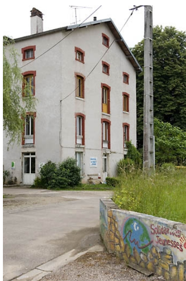
Elévation occidentale de l'atelier de fabrication. Phot. Jérôme Mongreville IVR43_20087000529NUC2A
