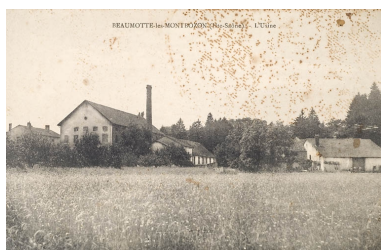
Beaumotte-les-Montbozon (Hte-Saône). - L'Usine. Phot. Jérôme Mongreville IVR43_20097000017NUC2A
