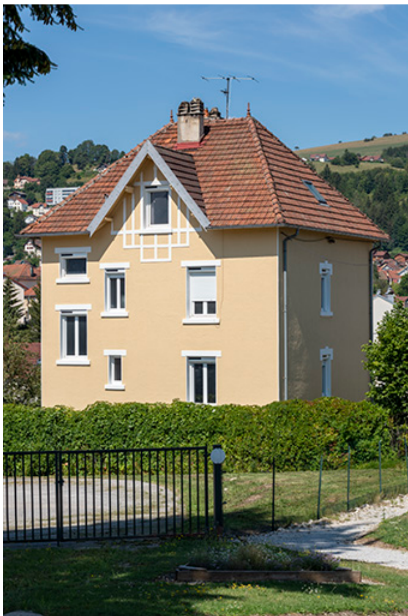
Façades postérieure et latérale gauche.
