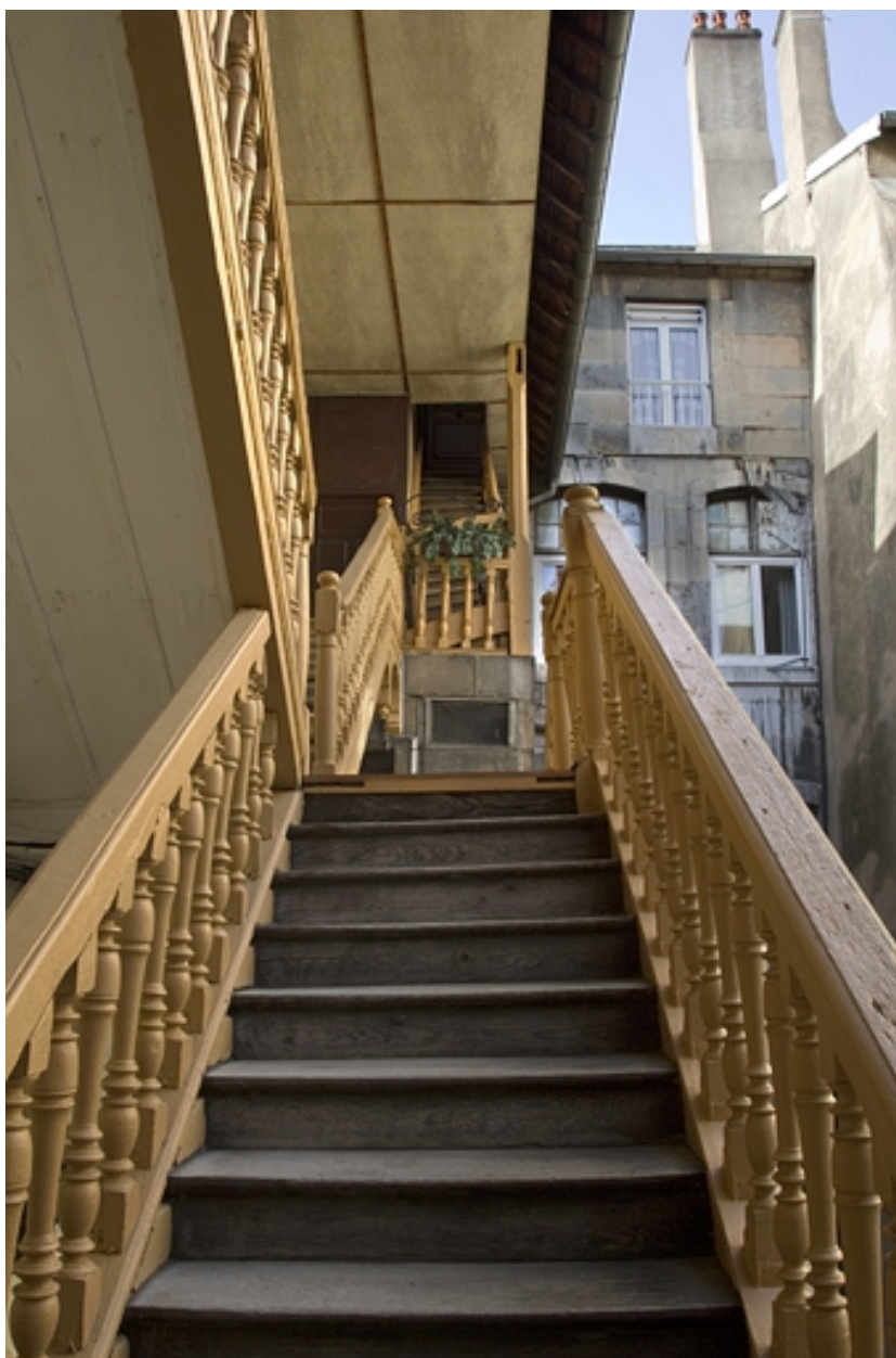
Première cour, escalier à cage ouverte : détail des dernières volées avec une rampe à balustres de bois tourné.
