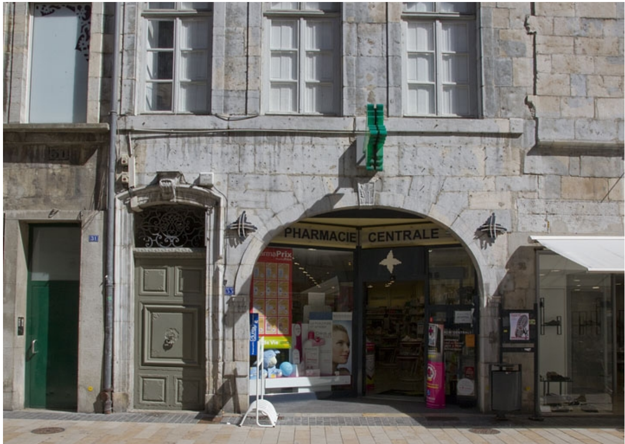
Logis principal, façade antérieure : détail du rez-de-chaussée.
