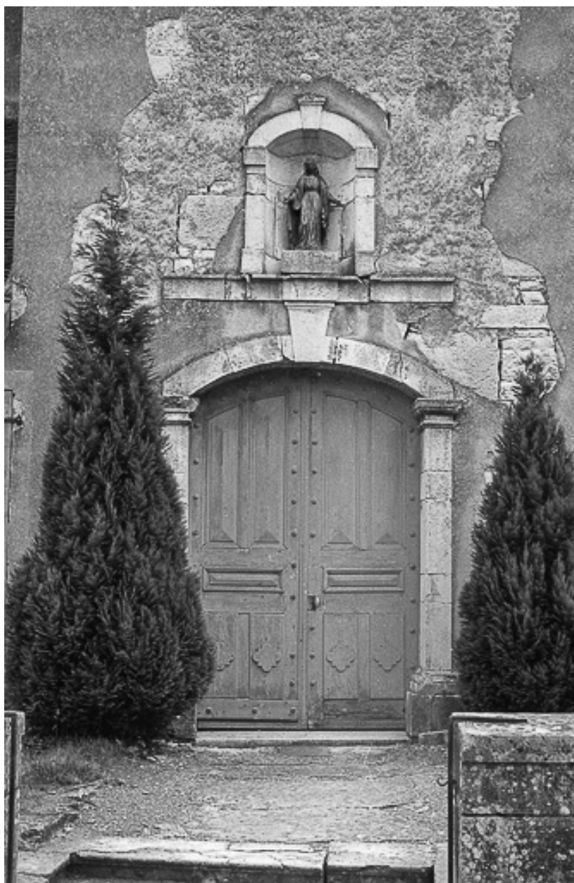
Extérieur : détail du porche de l'église.
