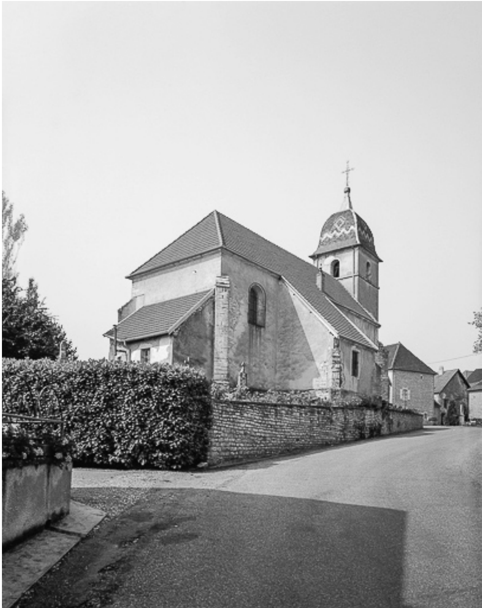
Extérieur : façades postérieure et latérale gauche.
