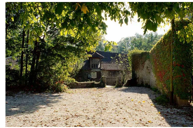
L'atelier de la forge depuis l'ouest. Phot. Yves Sancey IVR43_19973901058ZA
