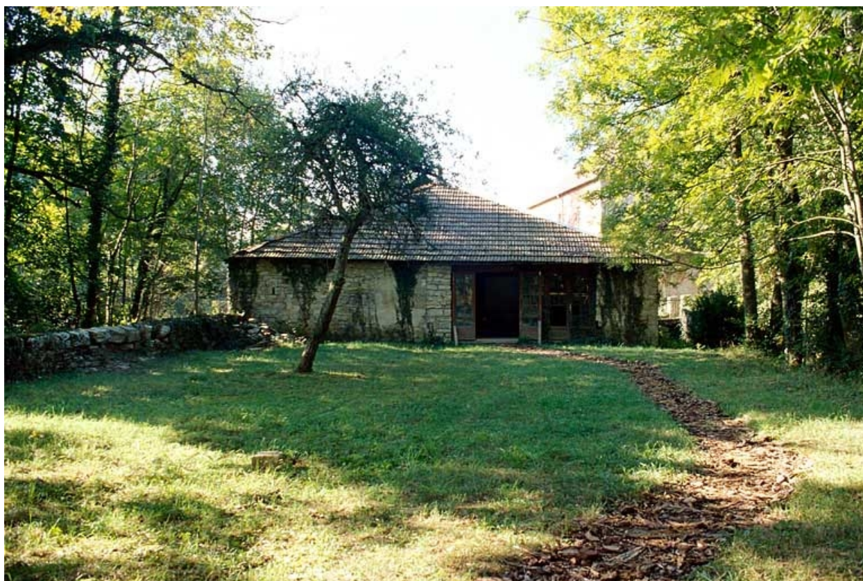
Extrémité ouest de l'atelier de la forge.
