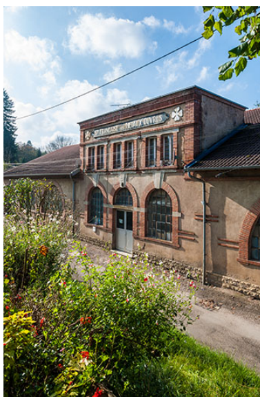
Travée centrale de l'atelier. Phot. Jérôme Mongreville IVR43_20142501644NUC4A
