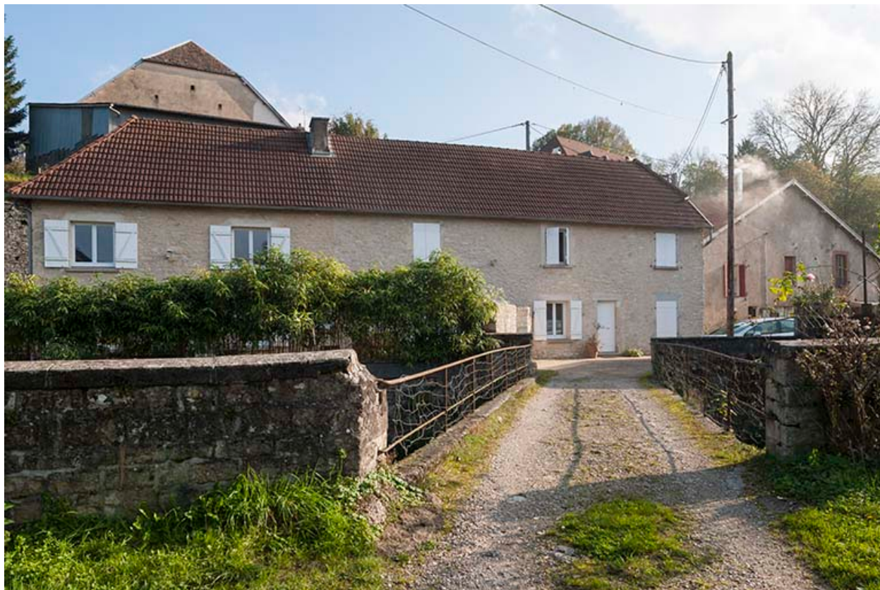
Façade ouest du logement patronal.
