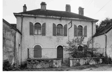
Façade antérieure en 1980. Phot. Jean- Marie NEPASUTILISERBaverel IVR43_19807000314Z
