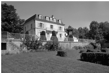
Demeure de notable dite le Château Phot. Jérôme Mongreville IVR43_19973900801X
