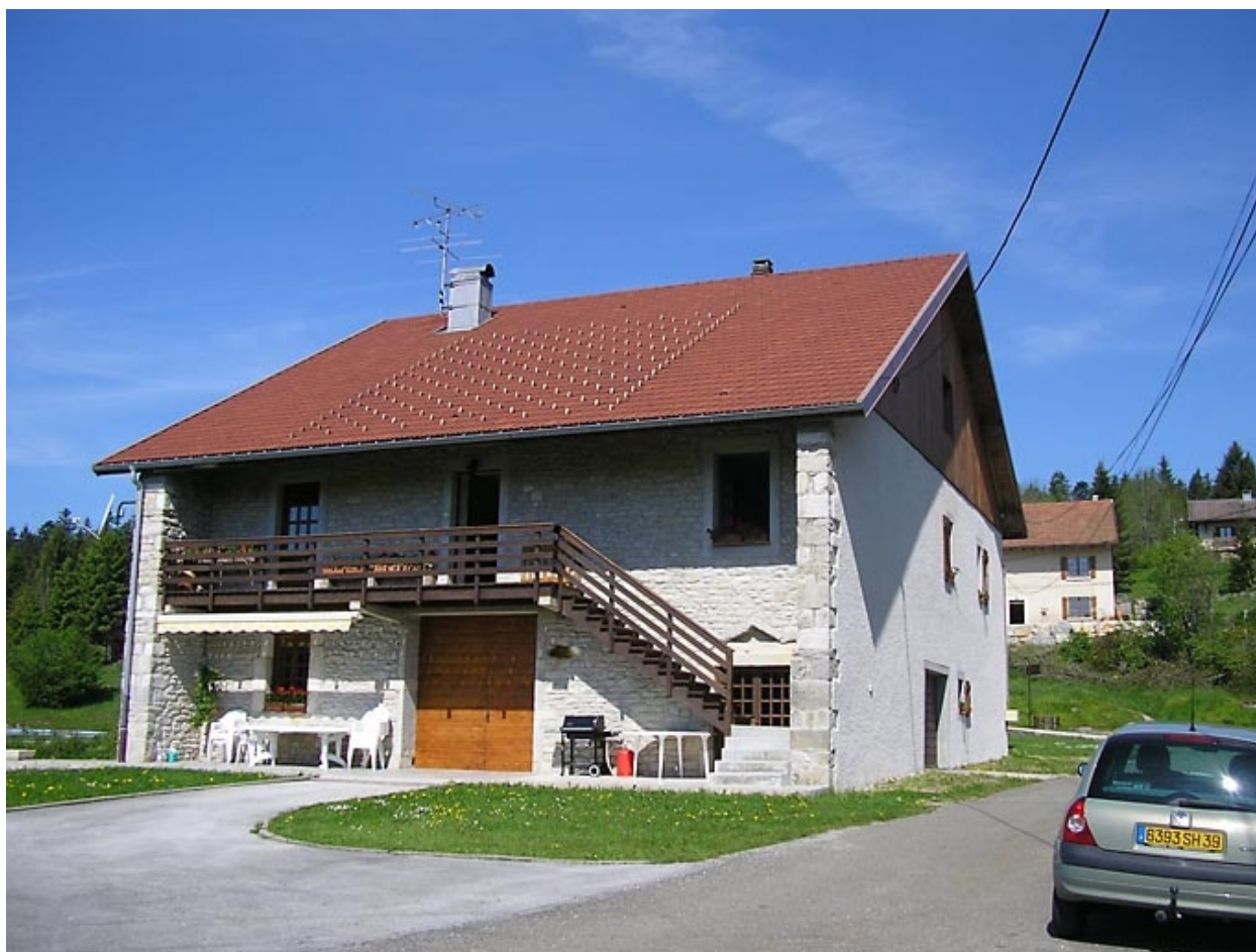
Façade postérieure et pignon sud-ouest.
