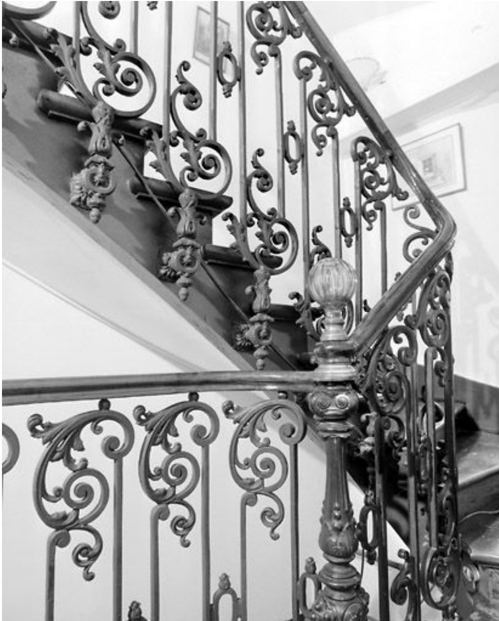
Escalier tournant : détail du garde-corps.
