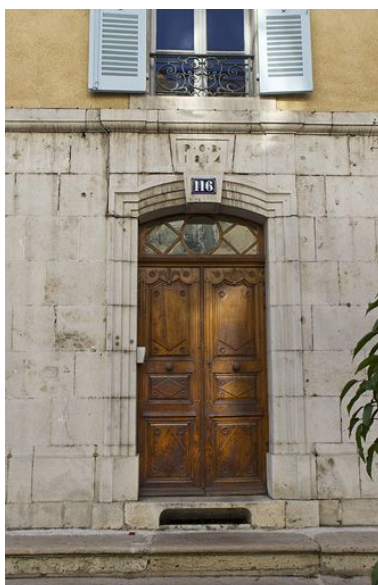
Façade antérieure : porte principale. Phot. Yves Sancey IVR43_20103900455NUC2A
