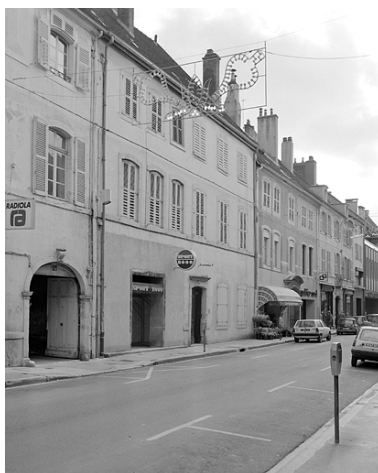
Maison située 13 rue Lafayette. Phot. Yves Sancey IVR43_19833900663X
