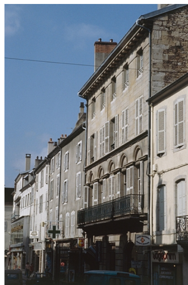
Maison située 20 rue Lafayette. Phot. Yves Sancey IVR43_19883900109ZA
