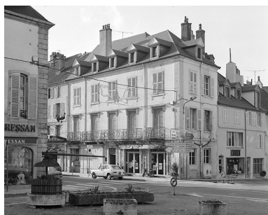
Maison située 2 rue Lafayette. Phot. Yves Sancey IVR43_19833900634X
