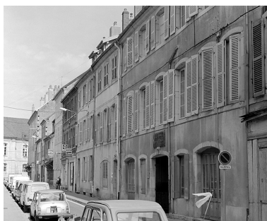
Maison située 19 rue Tamisier. Phot. Yves Sancey IVR43_19833900397X
