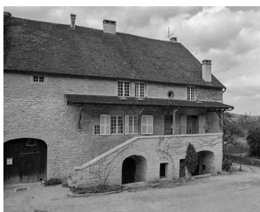
Ferme située impasse de la Bourcette. Phot. Jérôme Mongreville IVR43_19853900101X
