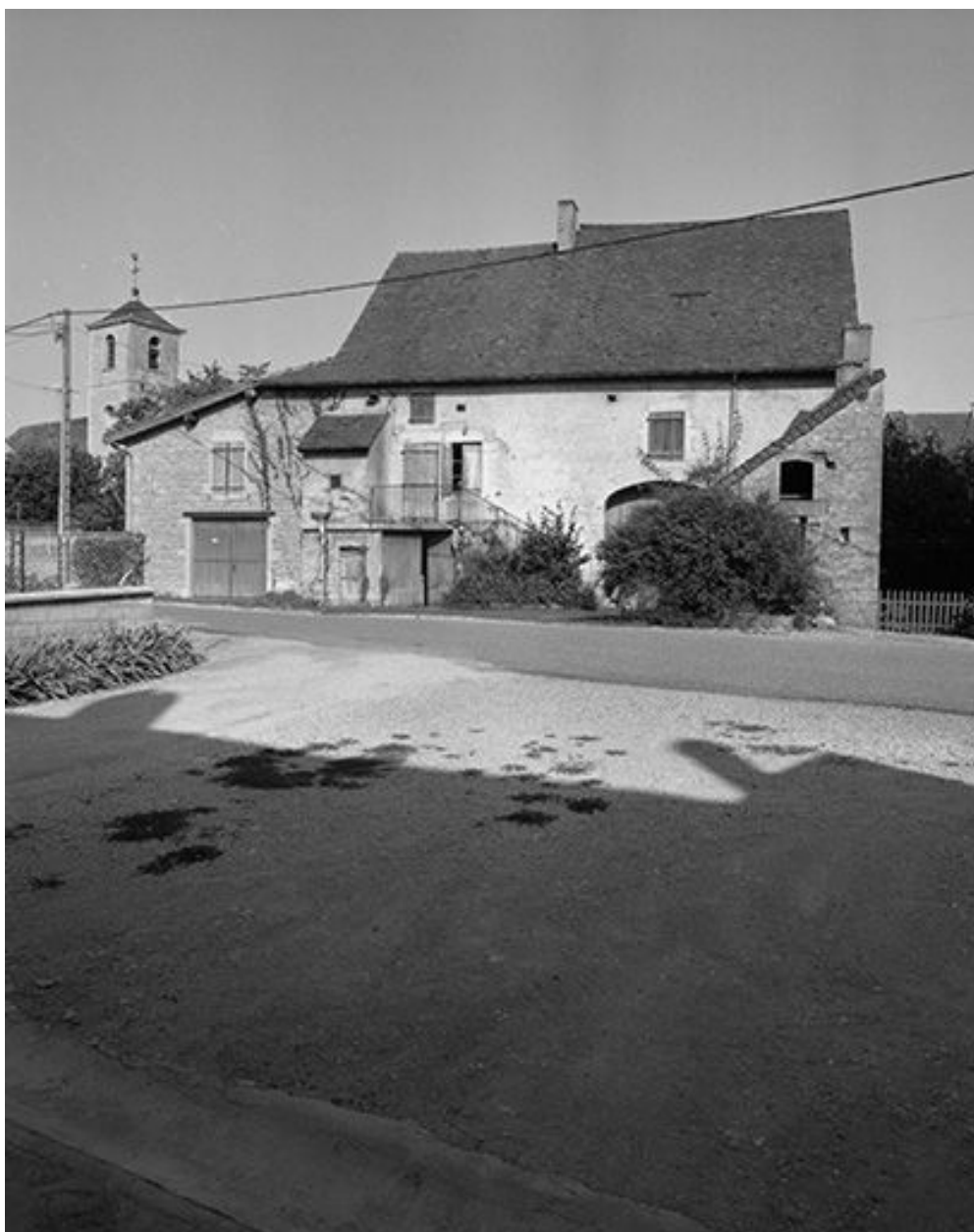
Ferme de vigneron située 3 route de Cesancey.
