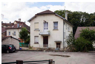
Façade latérale droite. Phot. Yves Sancey IVR43_20132501791NUC2A
