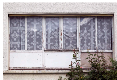
Façade antérieure : fenêtre d'atelier au rez-de-chaussée. Phot. Yves Sancey IVR43_20132501789NUC2A
