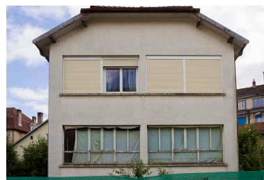
Façade latérale gauche. Phot. Yves Sancey IVR43_20132501790NUC2A
