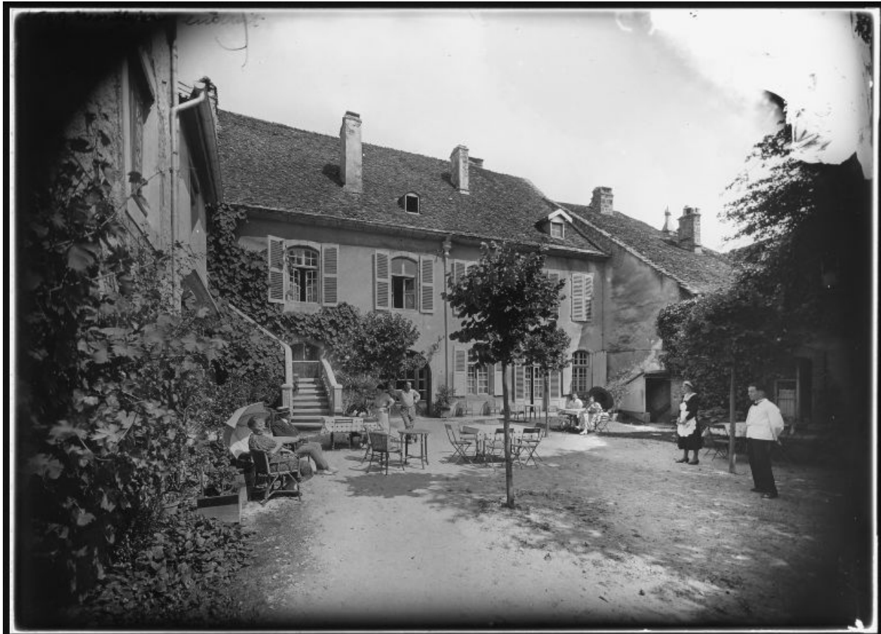
Cour intérieure [1re moitié 20e siècle].
