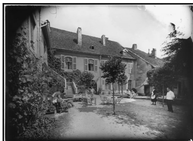
Cour intérieure [1re moitié 20e siècle].
