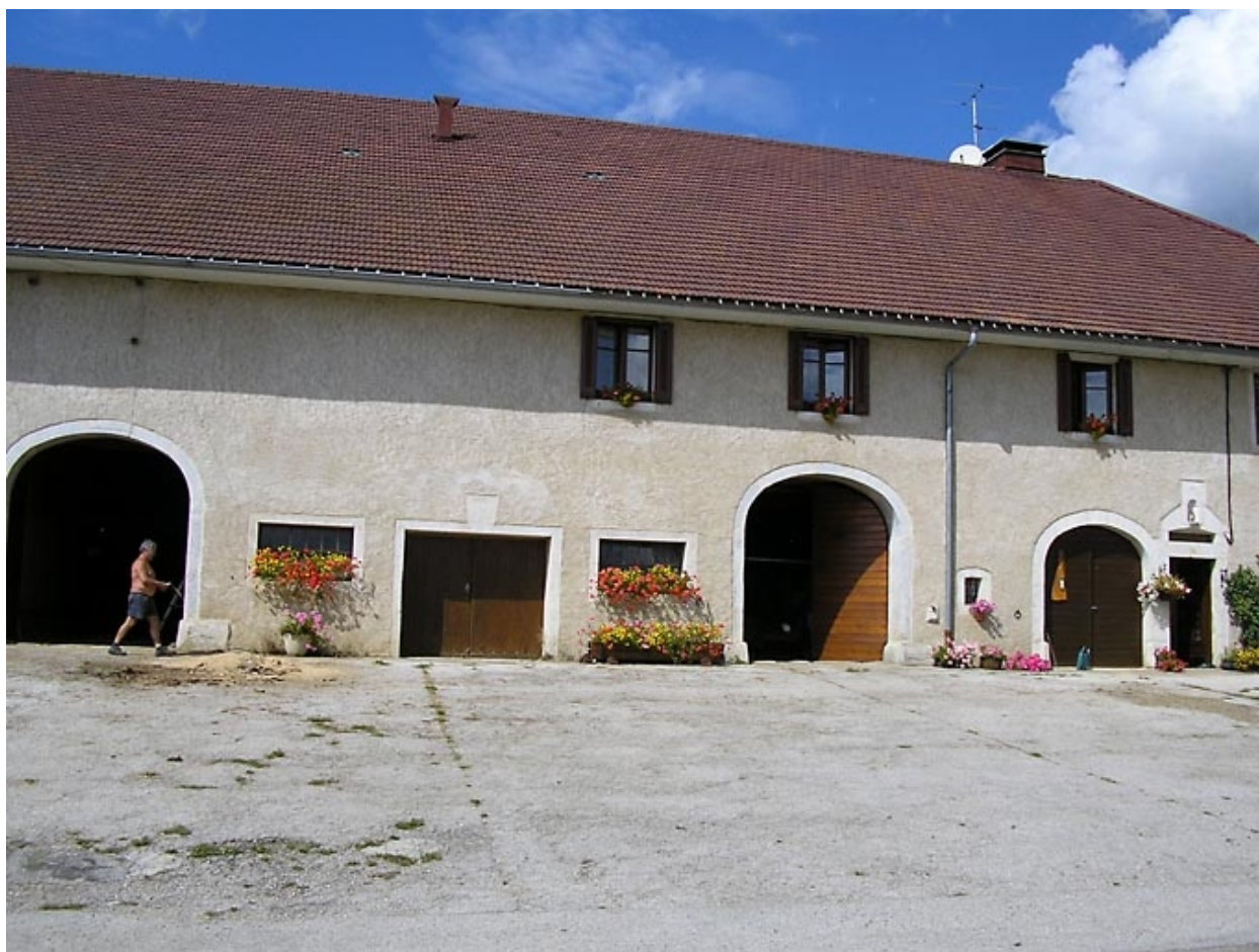
Vue latérale de la façade antérieure.
