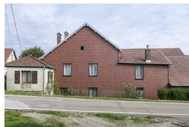
Elévation côté rue. Phot. Liliane Hamelin IVR43_20222500391NUC2A
