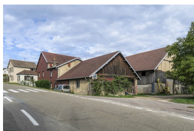
Vue d'ensemble, depuis le sud. Phot. Liliane Hamelin IVR43_20222500392NUC2A
