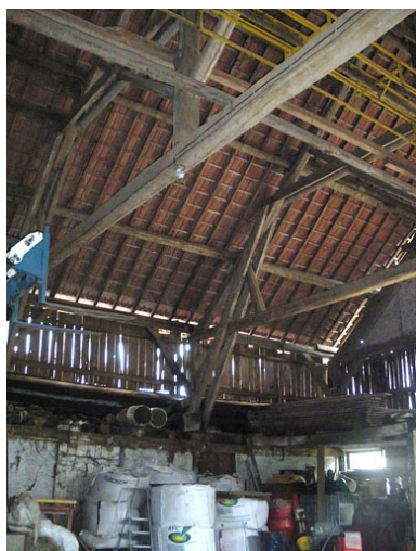
Remise agricole : charpente.
