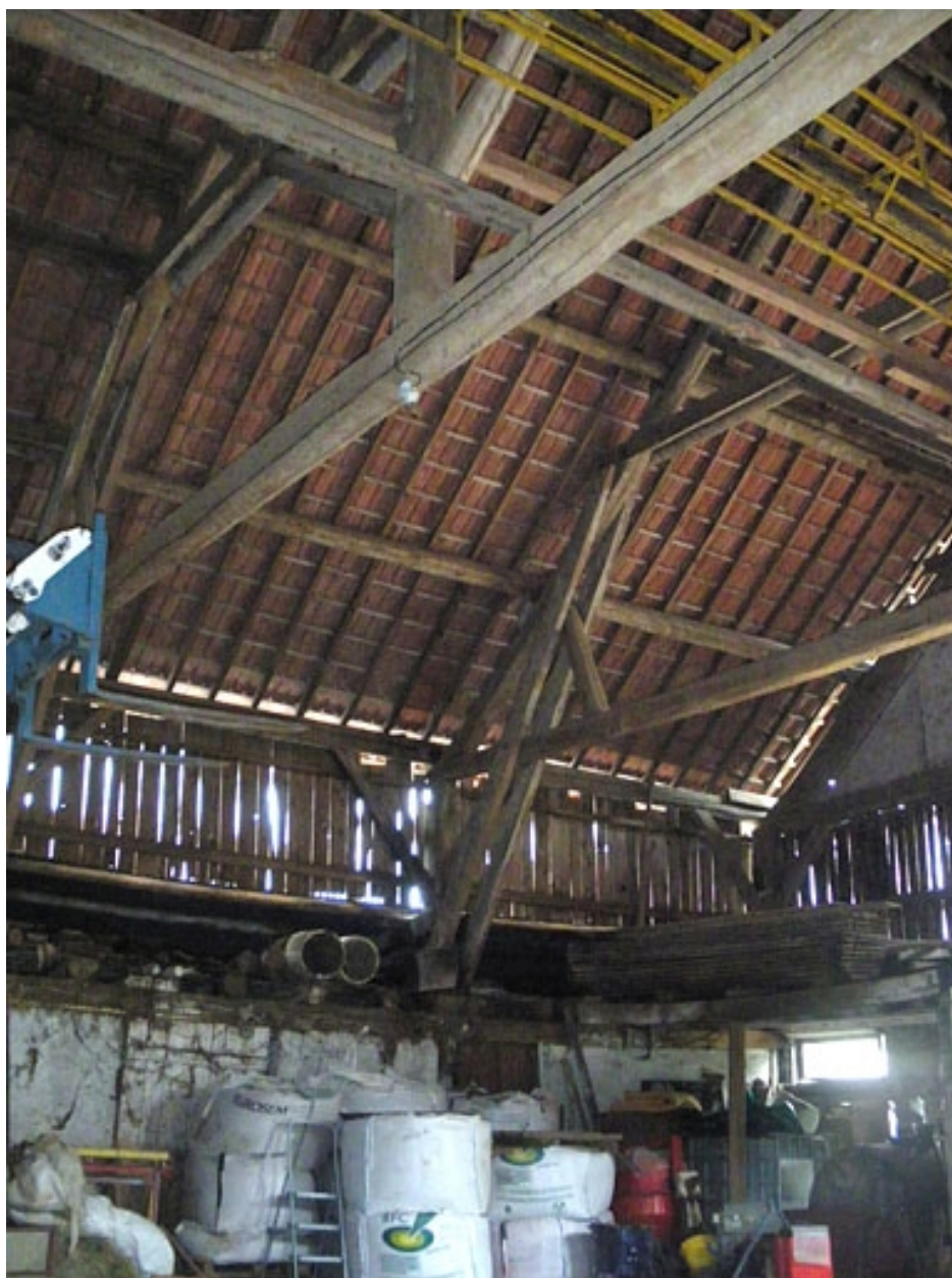
Remise agricole : charpente.
