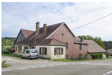
Vue d'ensemble, depuis l'ouest. Phot. Liliane Hamelin IVR43_20222500390NUC2A
