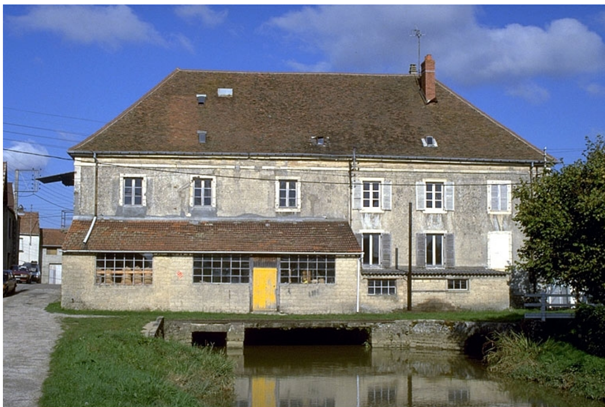
Façade postérieure de la minoterie.
