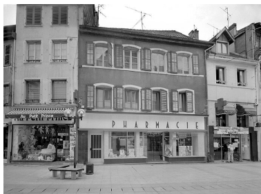
Façade sur la rue des Febvres. Phot. Jérôme Mongreville IVR43_19872501080V
