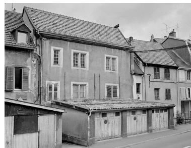
Façade sur la rue de la Schliffe. Phot. Jérôme Mongreville IVR43_19872500501X
