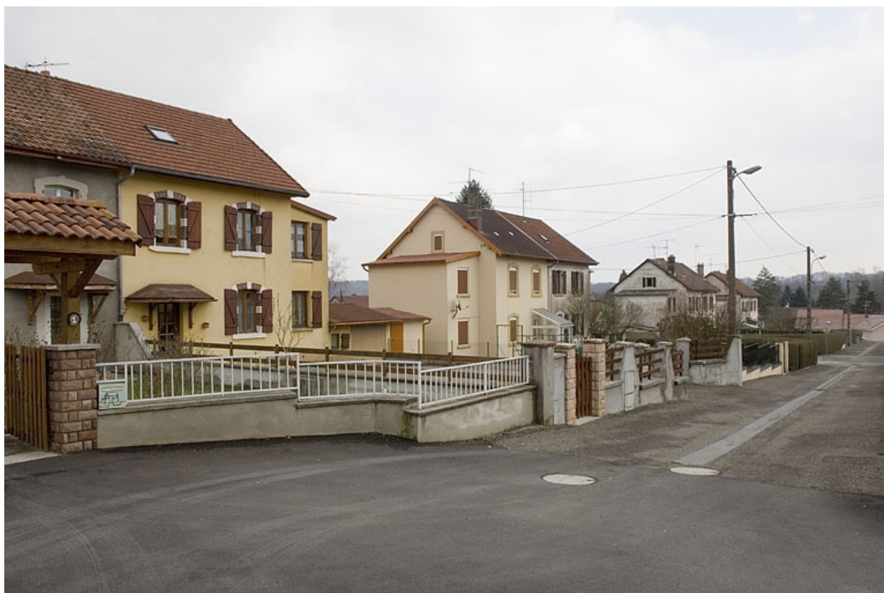
Maisons ouvrières rue de Wissembourg (côté impair).
