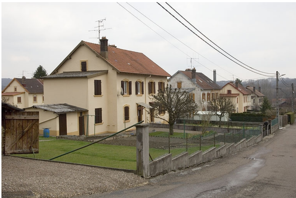
Maisons ouvrières rue de Thionville.
