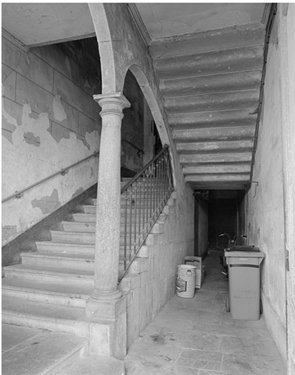
Vue de l'escalier depuis le vestibule.
