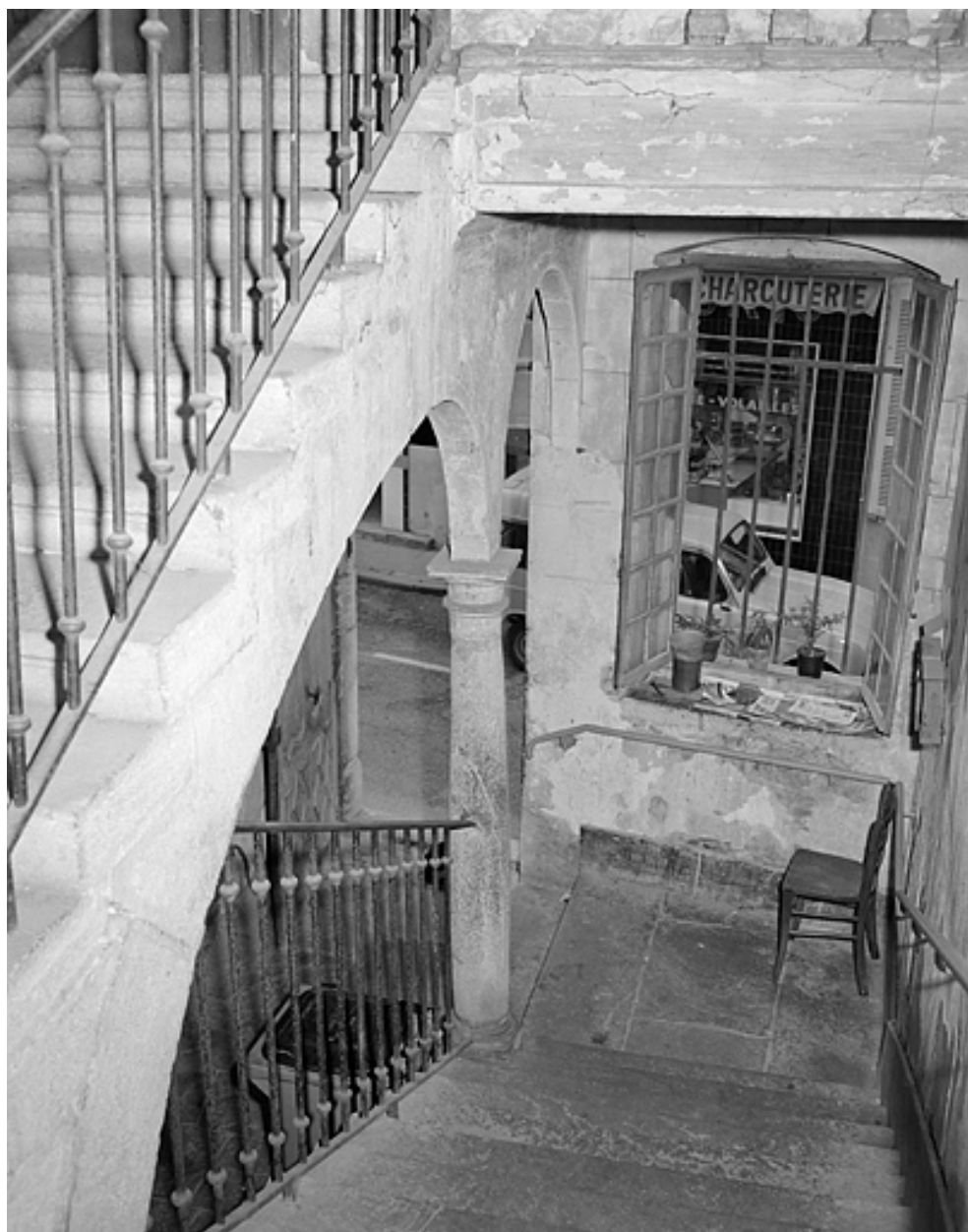
Escalier vu depuis le premier repos.
