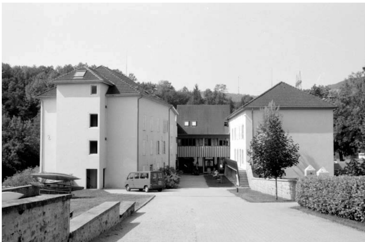
Atelier de fabrication et logement patronal.
