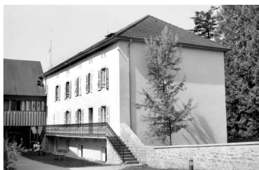
Logement patronal. Phot. Laurent Poupard IVR43_19923901185Z
