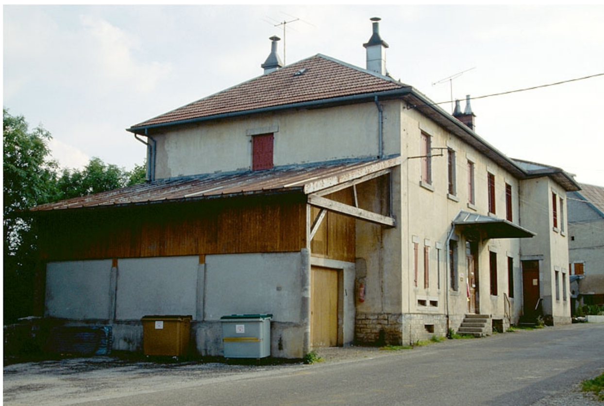
Façades antérieure et latérale gauche.
