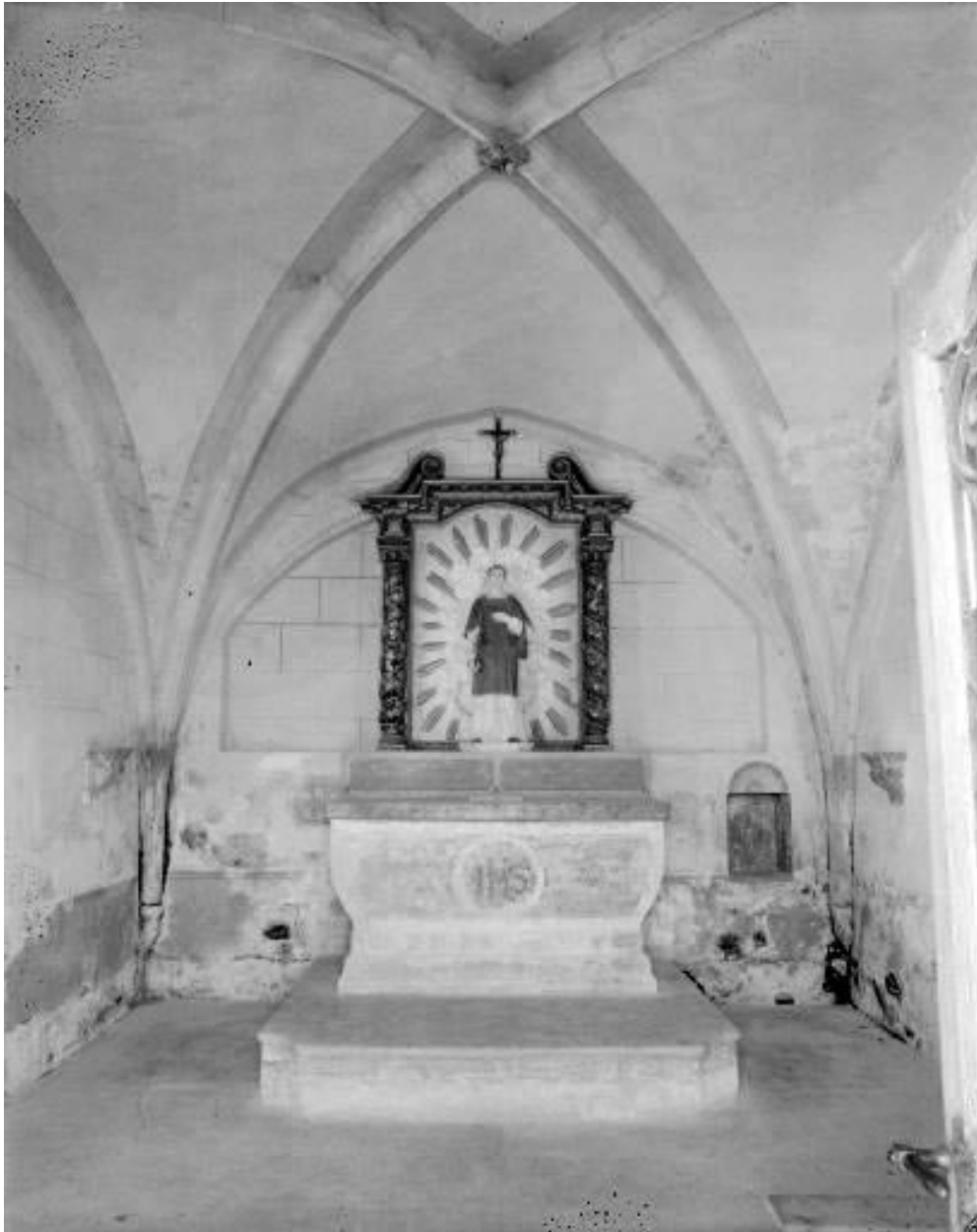
Intérieur : la nef vue depuis l'entrée.
