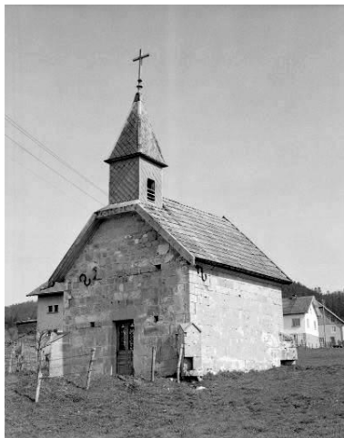
Extérieur : face antérieur et face latérale droite. Phot. Yves Sancey IVR43_19752500106X
