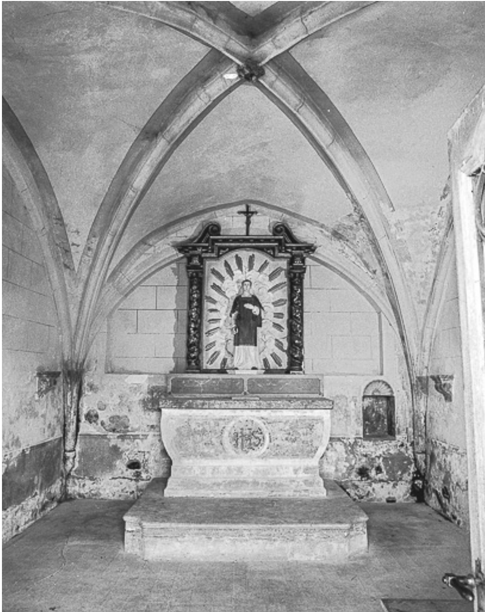
Intérieur : la nef vue depuis l'entrée.
