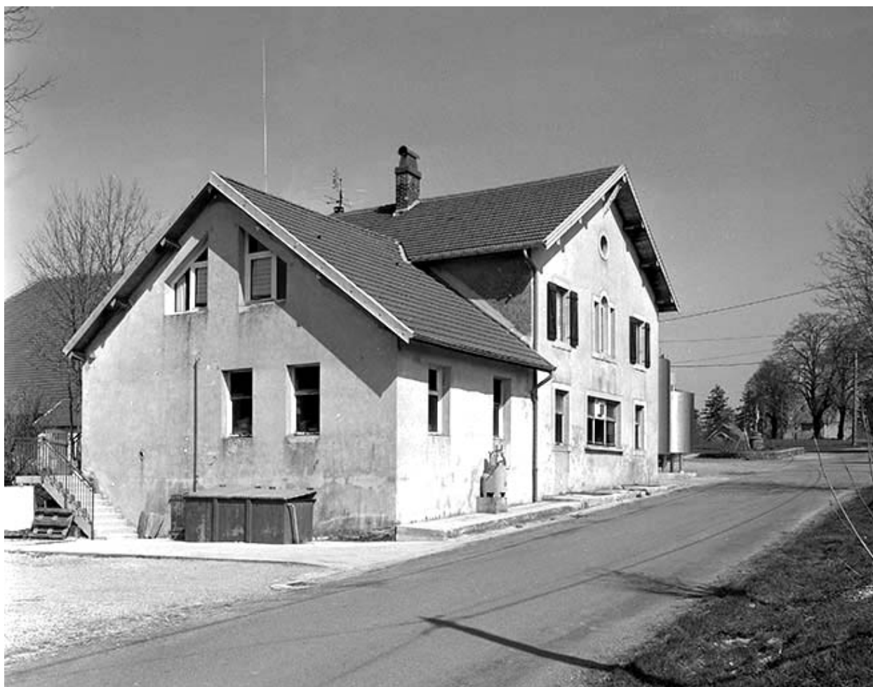
Façade sur rue de trois quarts gauche.
