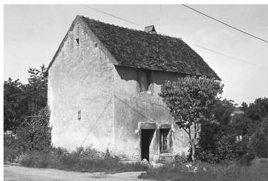
Maison située 24 rue de l'Eglise. Phot. Bernard Lardière IVR43_19817000647Z
