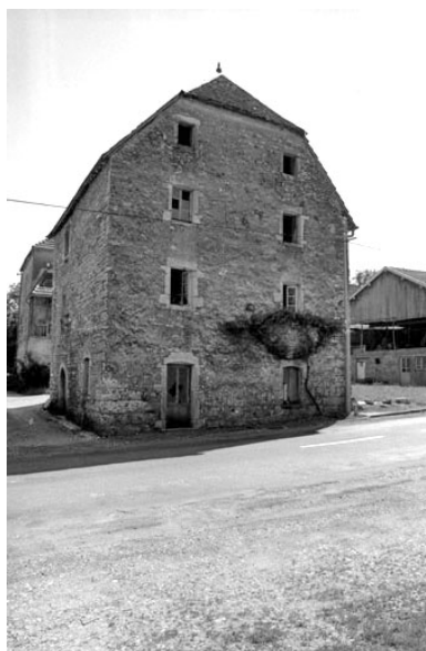
Maison située Grande Rue. Phot. Bernard Lardière IVR43_19817000657Z
