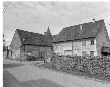
Bâtiments donnant sur la rue. Phot. Yves Sancey IVR43_19813900067X
