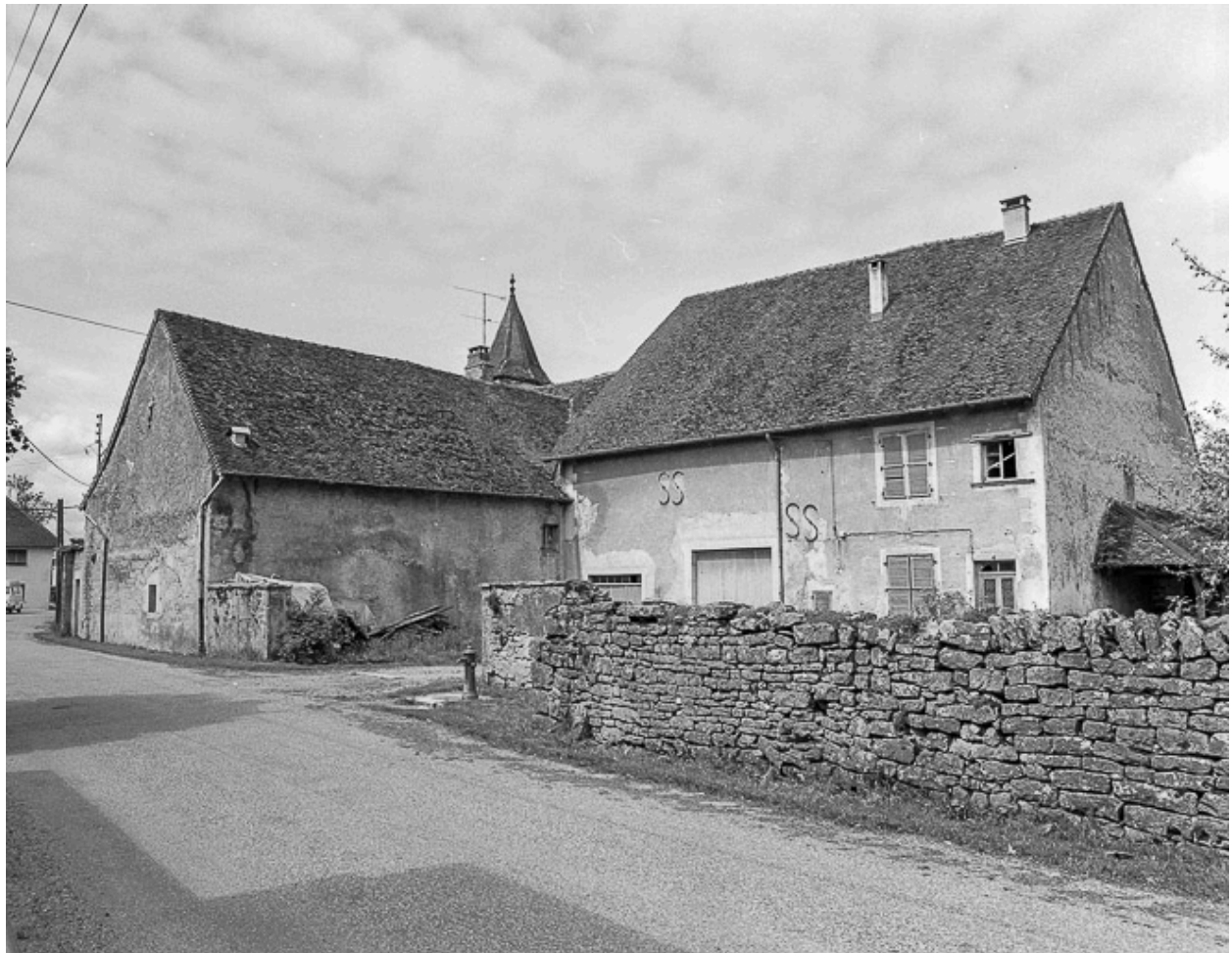
Bâtiments donnant sur la rue.
