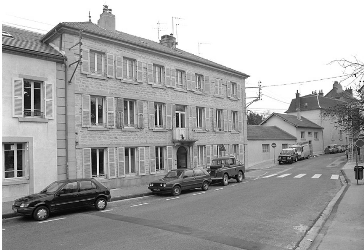
Façade antérieure du logement.
