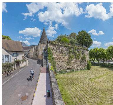
La Grosse Tour, vue depuis la tour des Bouchers.
