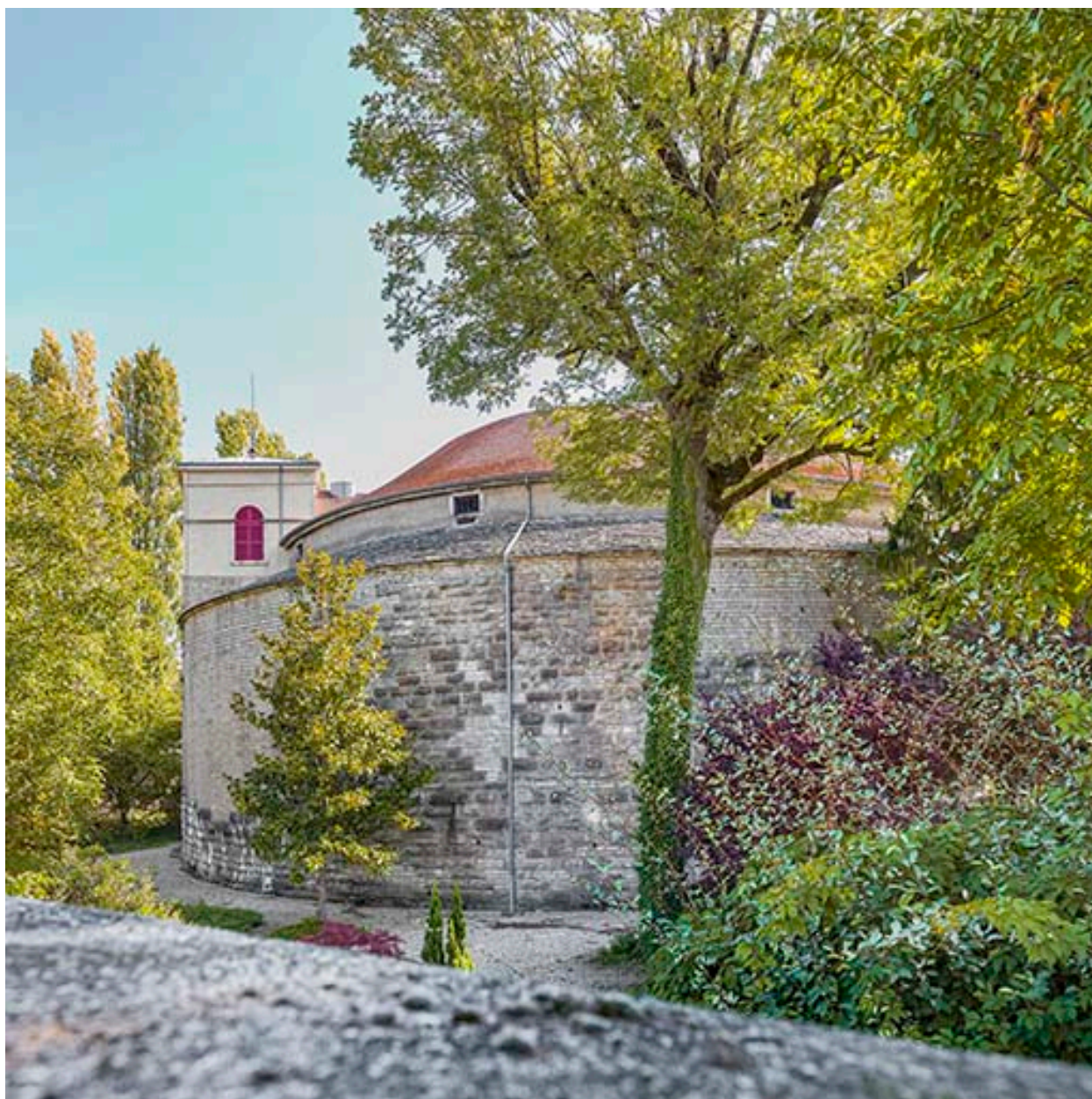
La tour des Filles.
