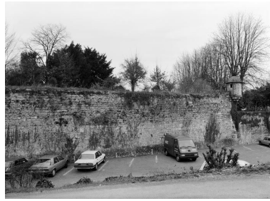
Bastion Sainte-Agathe (ou Sainte- Anne) : parapet sud et échauguette. Phot. Jean-Luc Duthu IVR26_19882101009V
