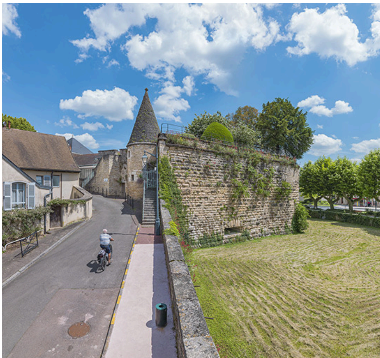
La Grosse Tour, vue depuis la tour des Bouchers.
