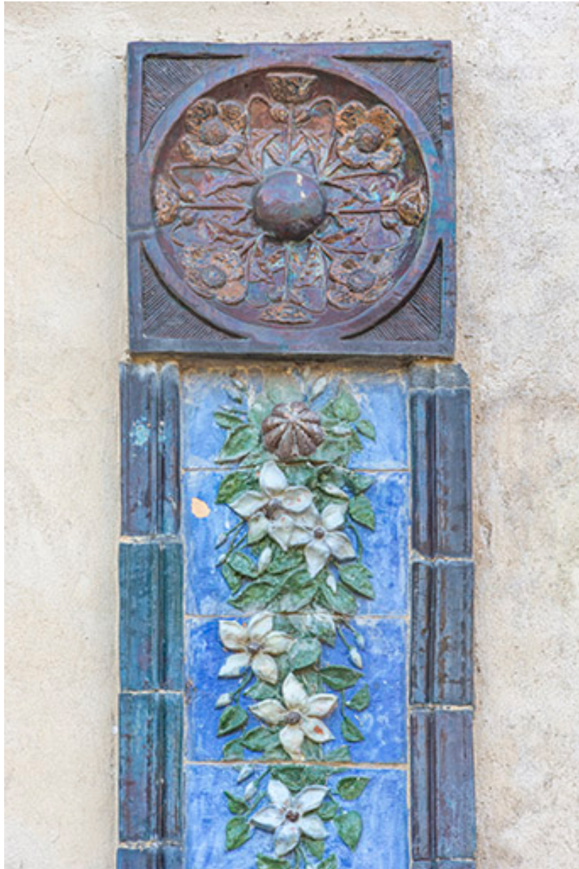
Façade nord. Extrémité supérieure du décor.
