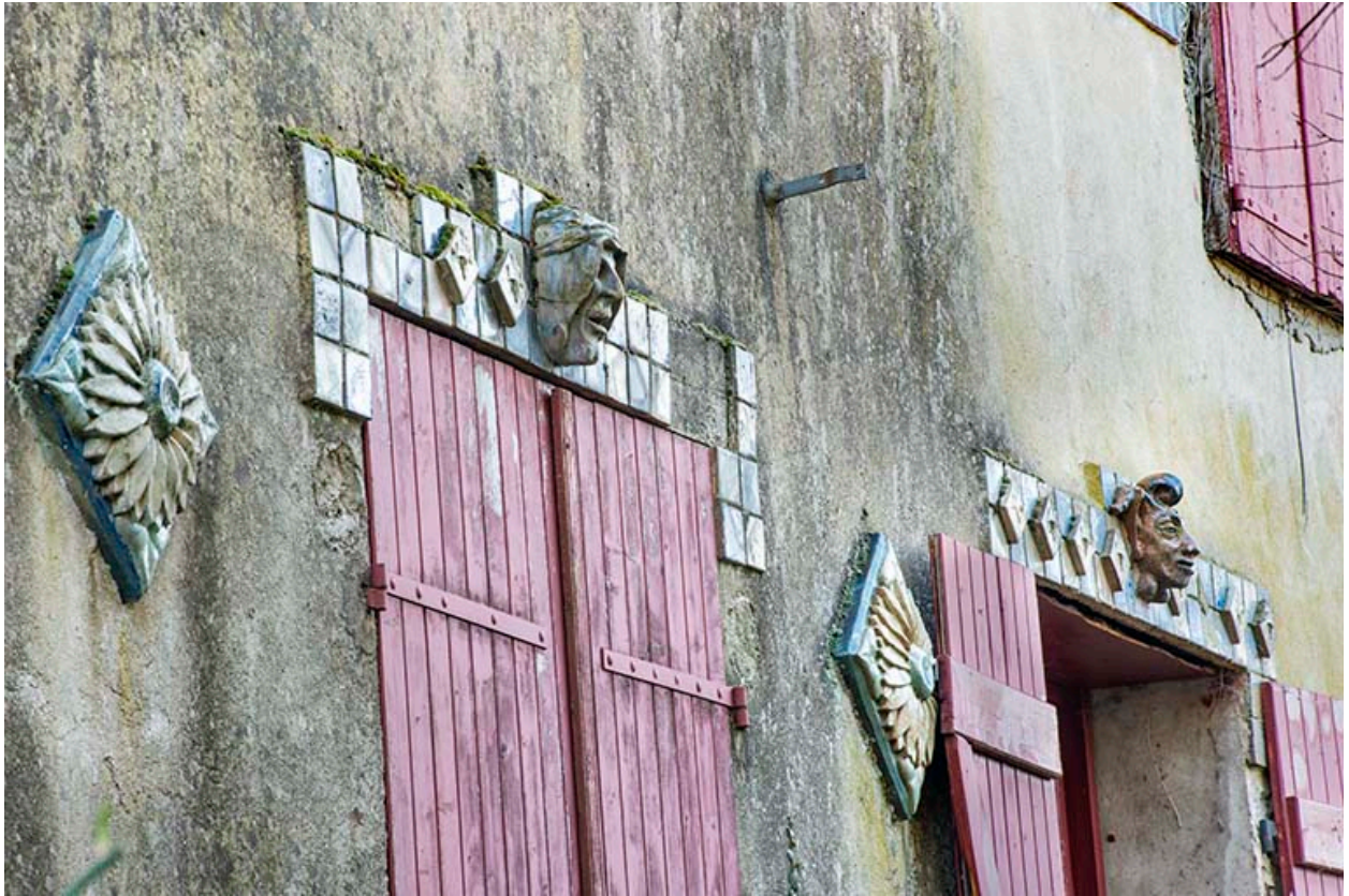
Façade ouest. Eléments de décor.
