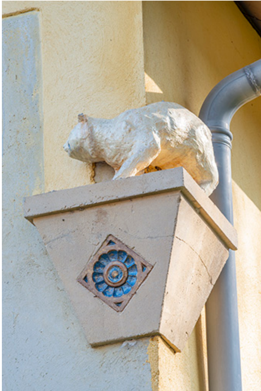
Angle sud-ouest du logement sud. Chat à l'affût sur une console.
