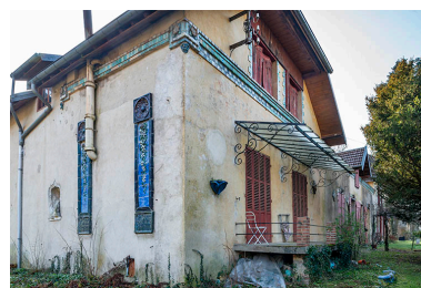
Vue d'ensemble depuis le nord-ouest. Phot. Jérôme Mongreville IVR43_20243900518NUC4A
