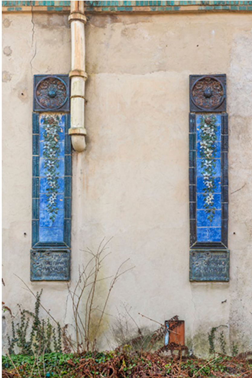
Plaques et carreaux de grès flammé apposés sur la façade nord.
