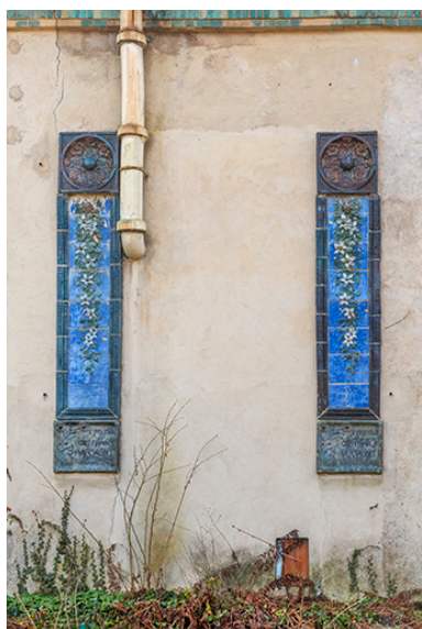
Plaques et carreaux de grès flammé apposés sur la façade nord. Phot. Jérôme Mongreville IVR43_20243900511NUC4A
