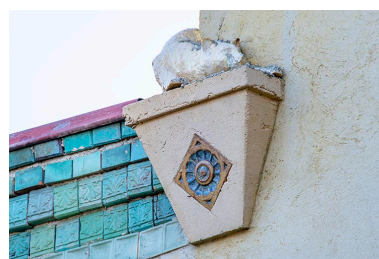
Angle nord-ouest du logement sud. Chat à l'affût sur une console.
