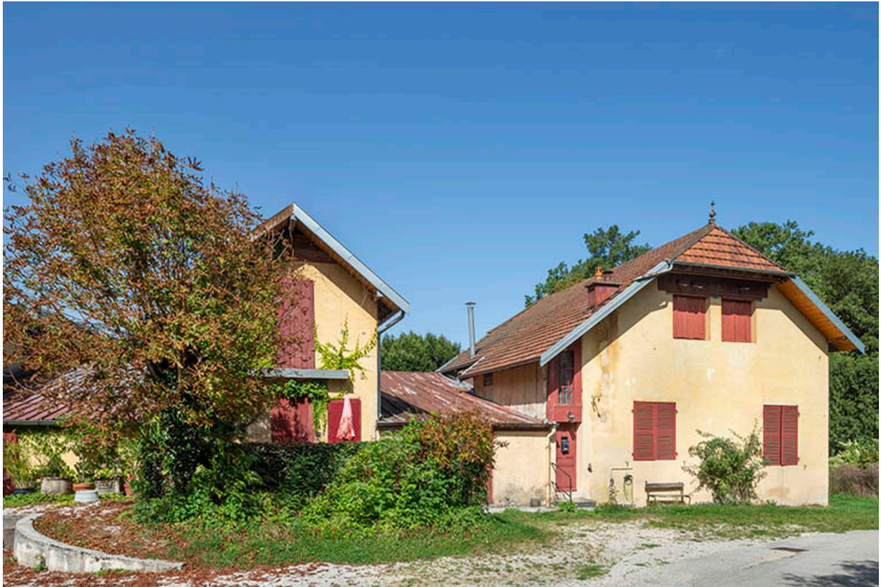
Atelier et logement nord depuis le chemin de Prailles.
