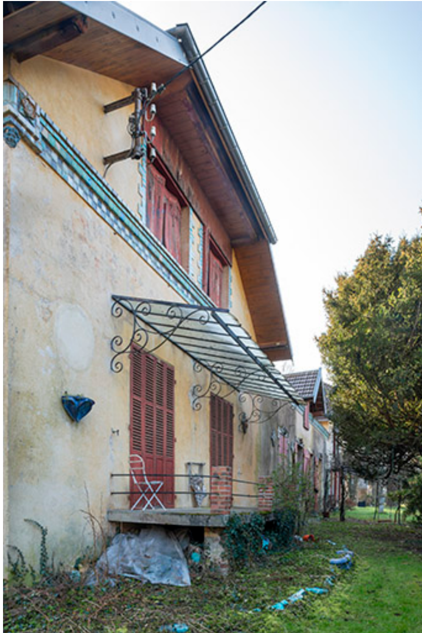
Vue de trois quarts des façades ouest.
