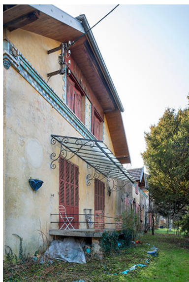
Vue de trois quarts des façades ouest.
