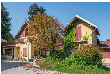
Logement sud et atelier depuis le chemin de Prailles. Phot. Jérôme Mongreville IVR43_20243900607NUC4A
