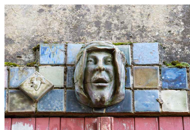
Façade ouest. Détail d'un mascaron sur un linteau de fenêtre.
