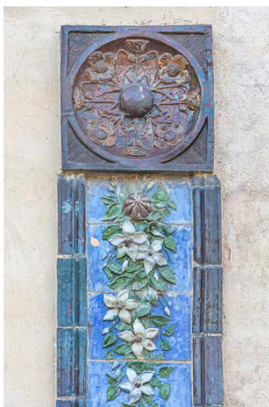
Façade nord. Extrémité supérieure du décor. Phot. Jérôme Mongreville IVR43_20243900515NUC4A
