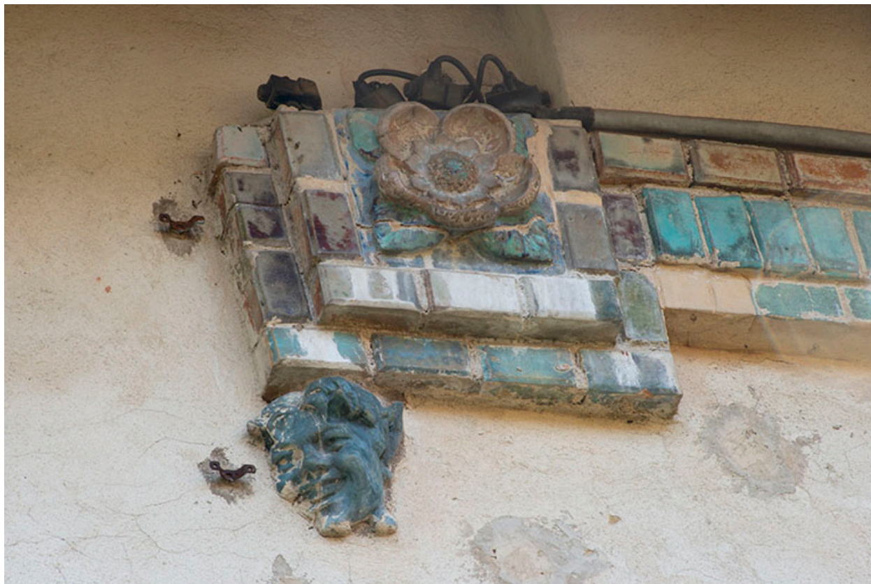
Façade nord. Extrémité de la frise.
