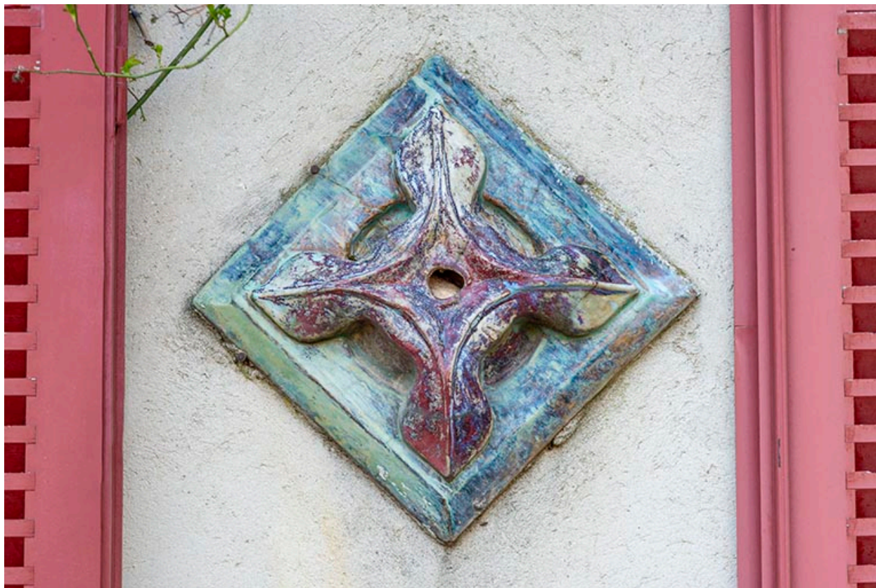
Façade ouest du logement. Détail d'un cabochon.
