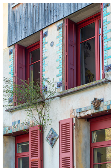
Mur pignon du logement sud.
