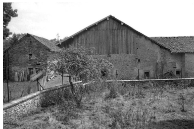
Vue générale depuis le nord-est. Phot. Gilbert Poinot IVR43_19762500849Z
