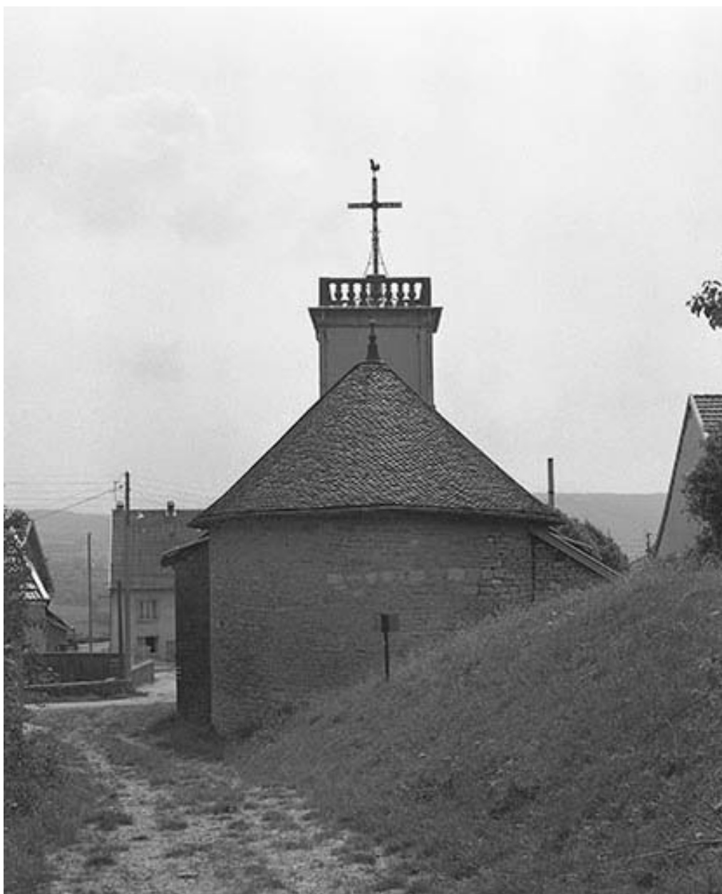
Extérieur : abside, vue de face.
