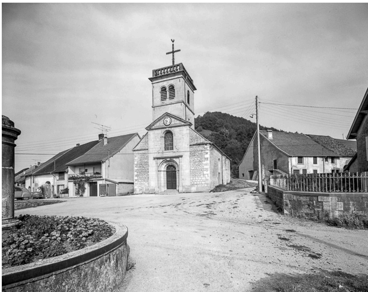
Extérieur : façade antérieure.
