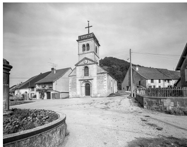
Extérieur : façade antérieure. Phot. Yves Sancey IVR43_19763900158V
