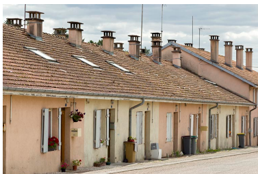
Maisons d'ouvriers. Phot. Sonia Dourlot IVR43_20157000721NUC2A
