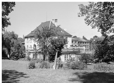
Vue d'ensemble depuis le jardin.
