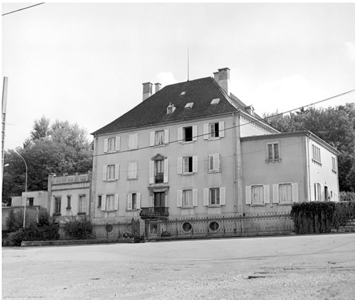
Façade sur rue en 1981.SRI. Enquête régionale sur les bâtiments industriels (1979-1981).
