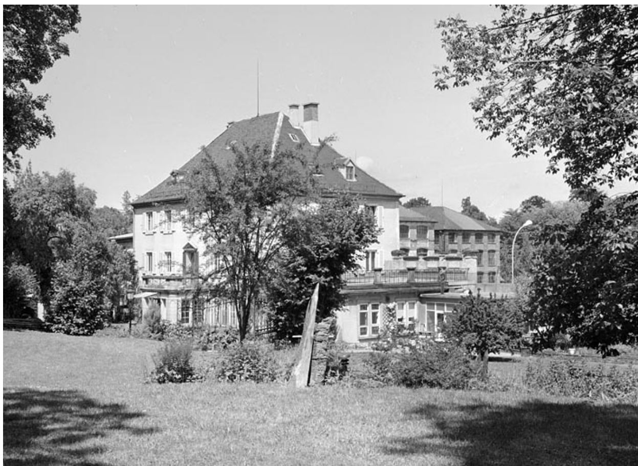
Vue d'ensemble depuis le jardin.
