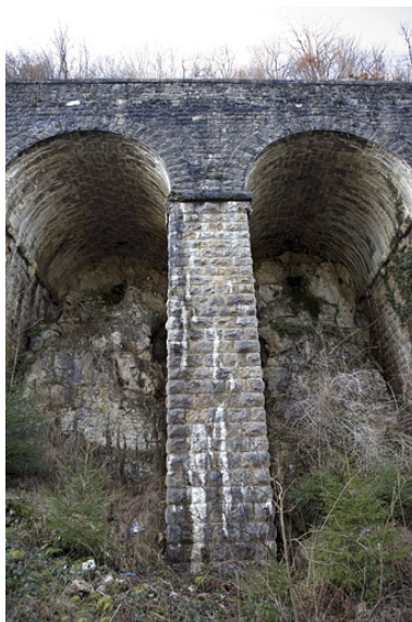
Deuxième mur à arcades : deux arches. Phot. Yves Sancey IVR43_20073900076NUCA
