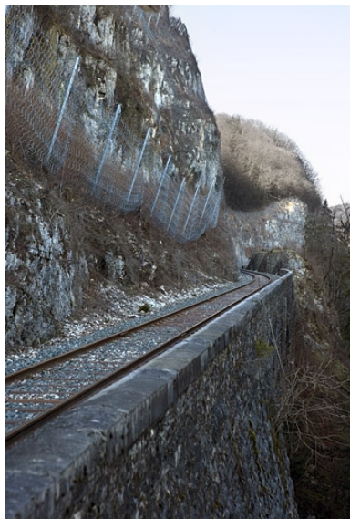
Mur de soutènement vers la vallée, depuis le côté La Cluse. Phot. Yves Sancey IVR43_20073900080NUCA
