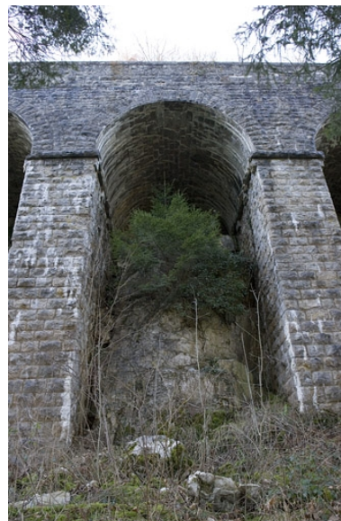
Deuxième mur à arcades : arche enjambant le rocher. Phot. Yves Sancey IVR43_20073900079NUCA
