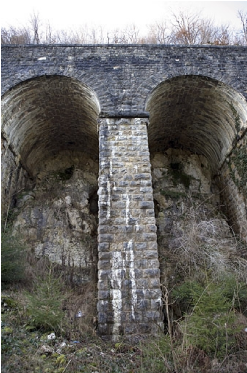
Deuxième mur à arcades : deux arches.
