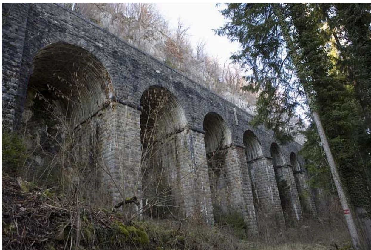
Deuxième mur à arcades : vue de trois quarts droite.
