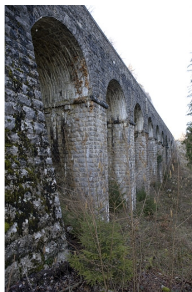
Deuxième mur à arcades : vue en enfilade, depuis le côté La Cluse. Mur débutant au PK 020.411. Phot. Yves Sancey IVR43_20073900078NUCA
