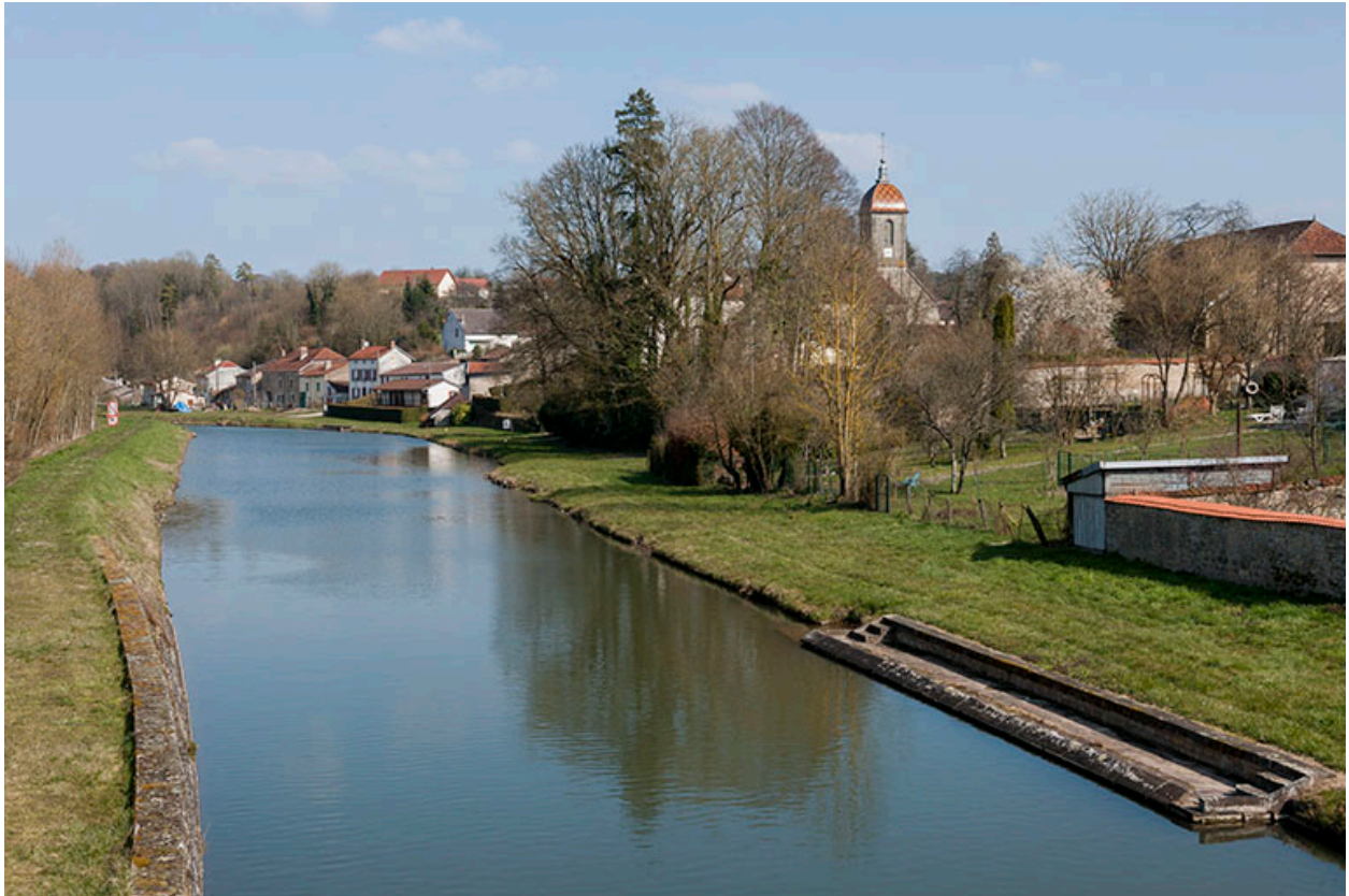
Le bief construit à Ormoy, afin de relier Corre à Port-sur-Saône.
