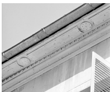
Détail de la corniche. Phot. Yves Sancey IVR43_20033900359X
