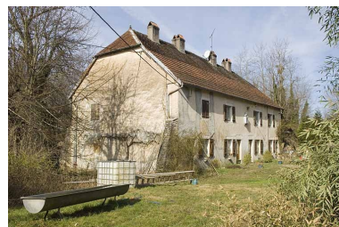
Logement d'ouvriers. Vue de trois quarts. Phot. Jérôme Mongreville IVR43_20097000163NUC2A
