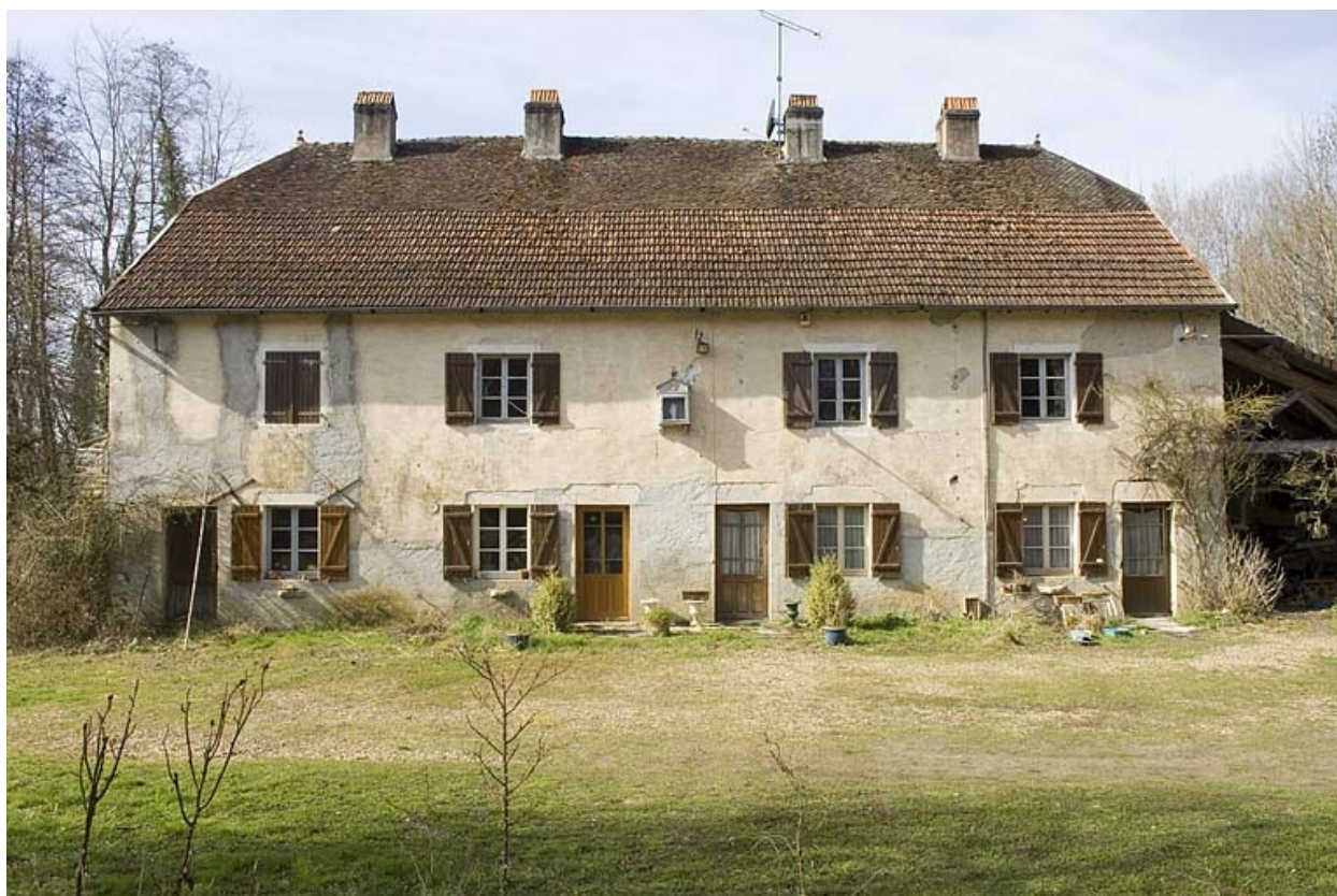
Logement d'ouvriers. Façade antérieure.
