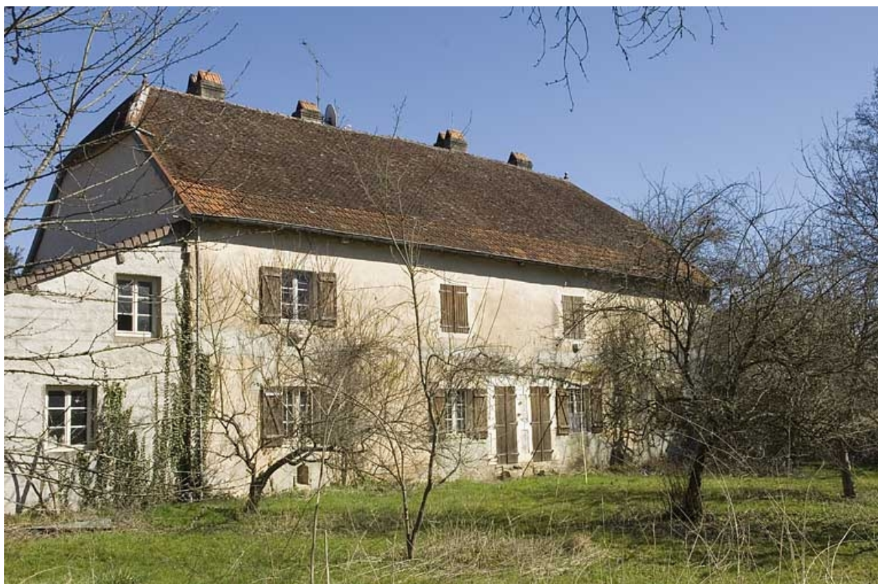
Logement d'ouvriers. Façade postérieure.
