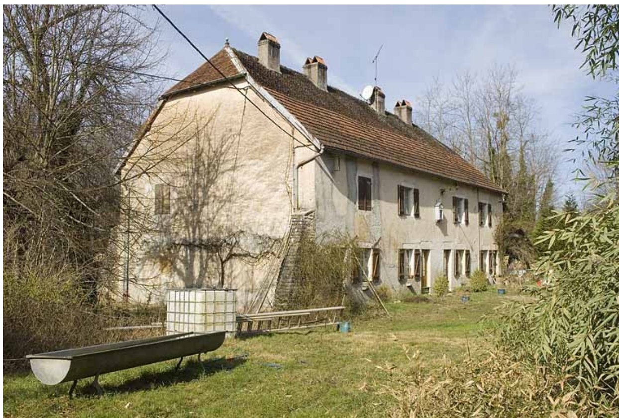
Logement d'ouvriers. Vue de trois quarts.
