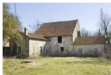
Logement et dépendances. Phot. Jérôme Mongreville IVR43_20097000175NUC2A
