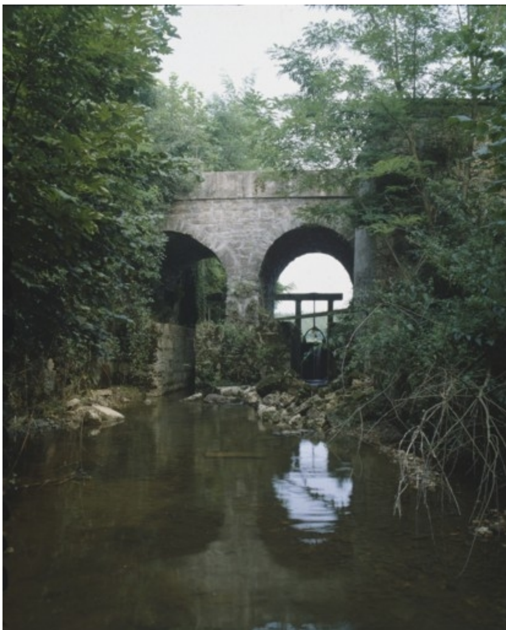
Canal de décharge en 1989.
