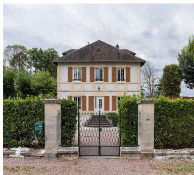
Vue actuelle depuis la voie publique. Phot. Pierre-Marie Barbe-Richaud IVR26_20205800625NUC4AQ
