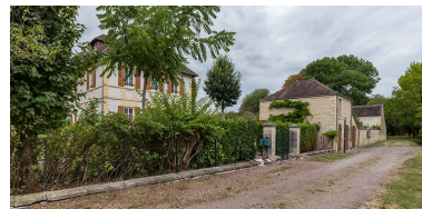
Vue actuelle depuis la voie publique. Phot. Pierre-Marie Barbe-Richaud IVR26_20205800626NUC4AQ
