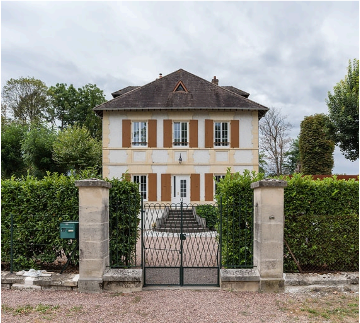
Vue actuelle depuis la voie publique.
