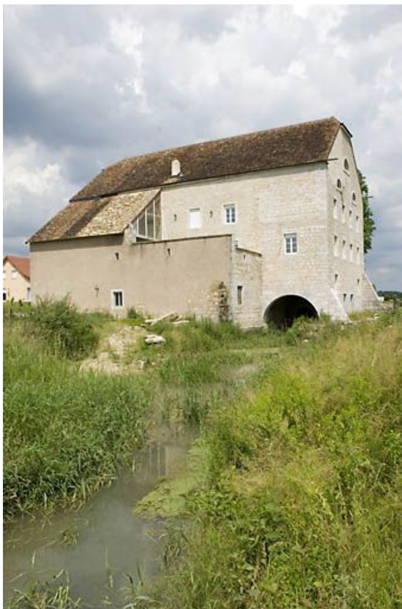
Vue d'ensemble depuis le bief d'aval.
