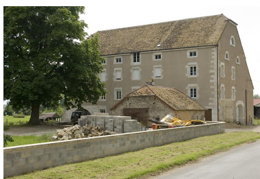
Vue du moulin depuis le nord-est. Phot. Jérôme Mongreville IVR43_20087000556NUC2A
