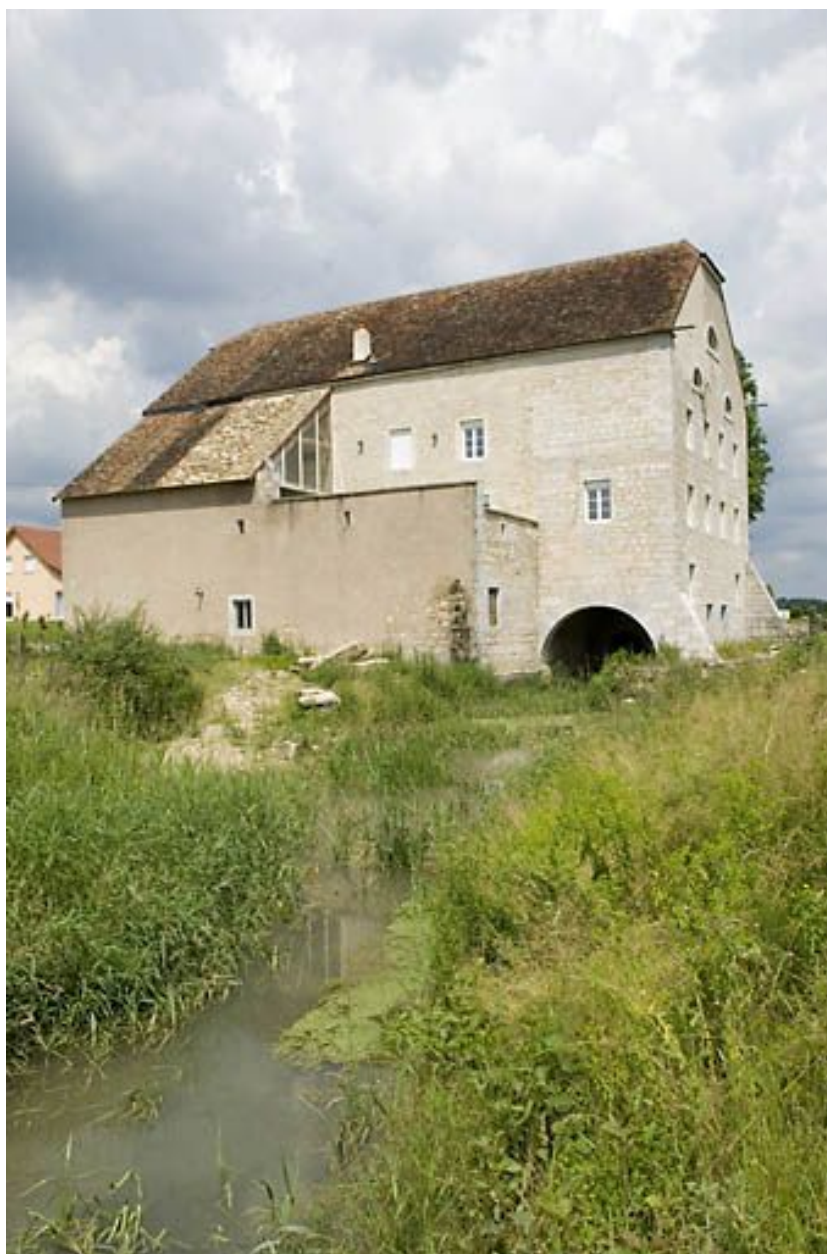
Vue d'ensemble depuis le bief d'aval.
