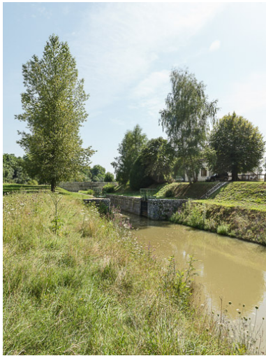
Vue du site d'écluse.
